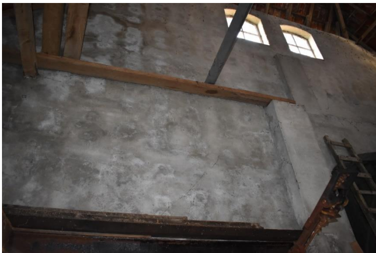
Binnenzijde muur afgesmeerd met cementlaag.
