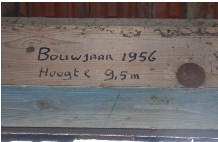
Aangegeven bouwjaar op houten ligger in buitengevel.
