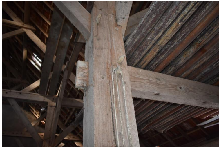
Pen-en-gaat verbindingen met toognagels.
