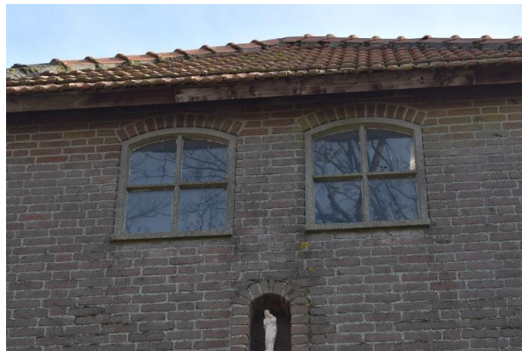
Twee betonvensters onder getoogde rollaag.
