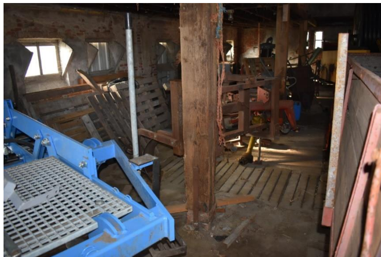
Delen van de mestput aanwezig in de vloer.
