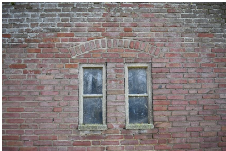
Dubbel betonvenster met doorlopende ontlastingsboog.
