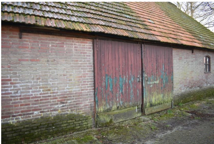
Opgeklampte houten schuifdeur, te zien is dat groen de eerder kleurstelling was.
