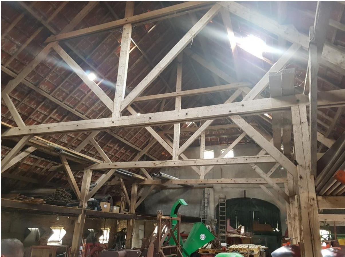
Figuur 4 | Spant- en kapconstructie
