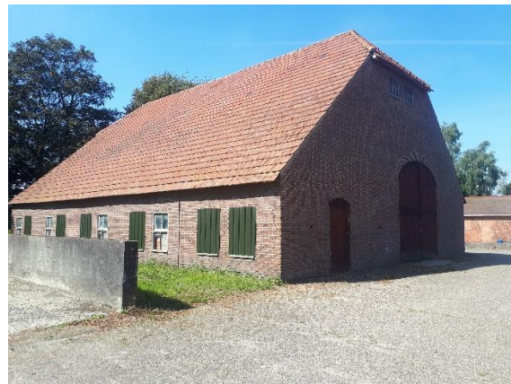
Figuur 3 | achter- en rechterzijgevel schuur
