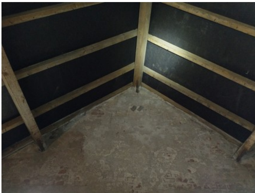
Binnenzijde Opstal 3. Onderzijde nieuwe dakbedekking, afgedicht met kunststofzeil. Foto: V. Stuit | Ecoresult B.V.
