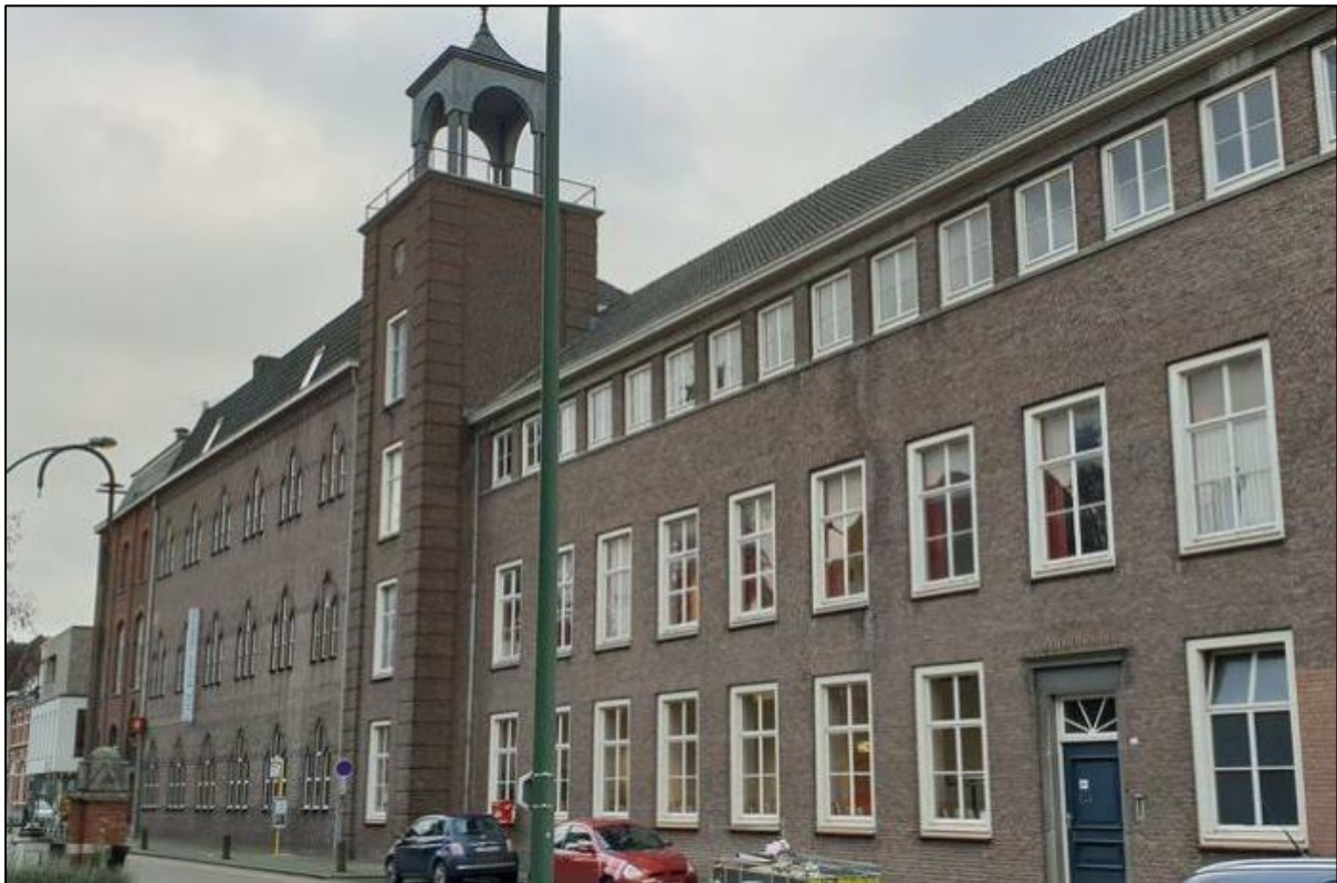
Foto bestaande Cultuurcentrum Baarle. Bron: Google maps, 2021.
