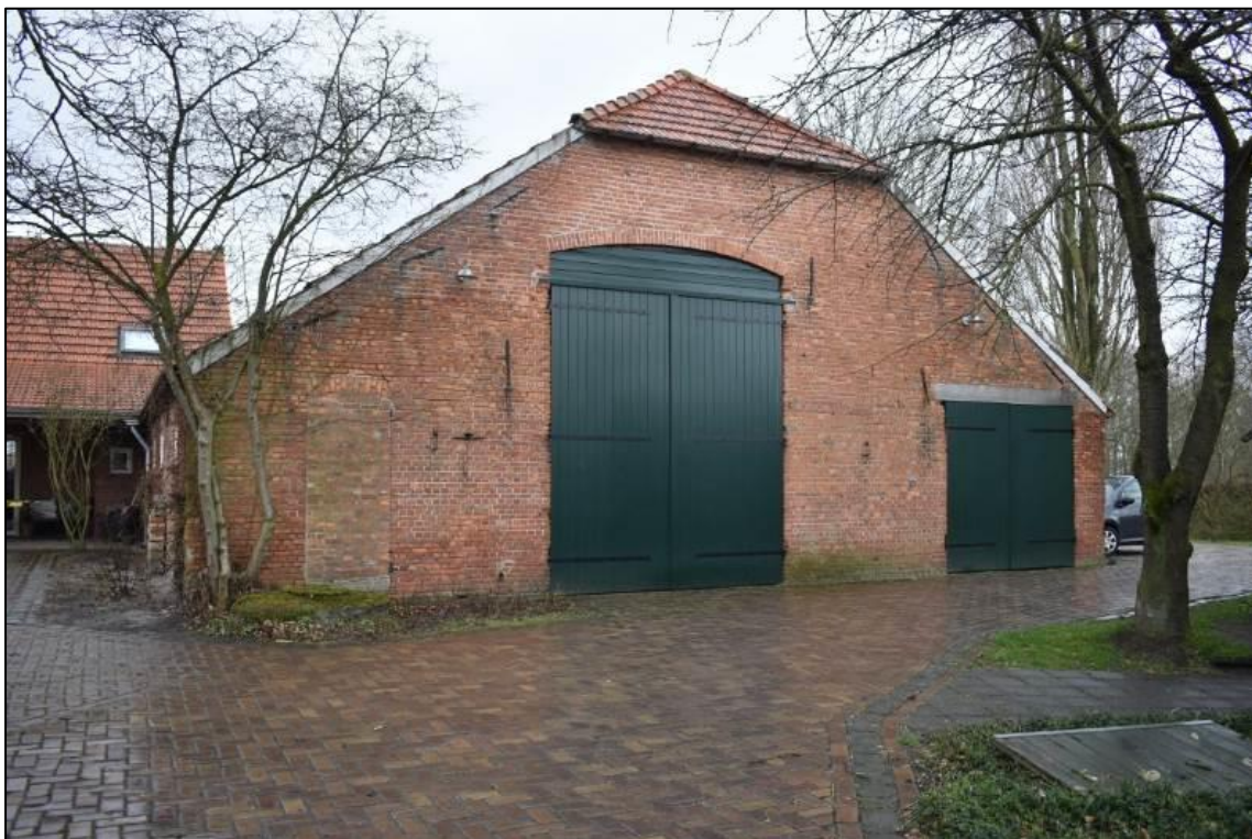
Afbeelding 6: Achtergevelaanzicht, bron: redengevende omschrijving Monumentenhuis Brabant b.v.
