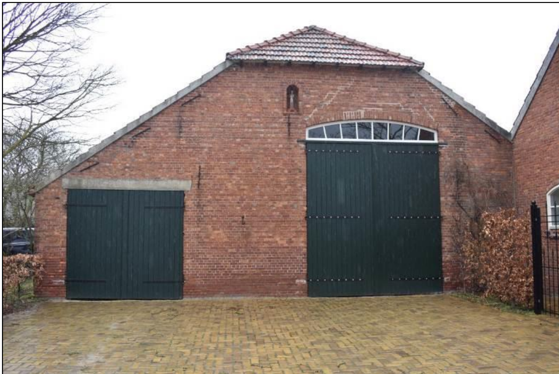
Afbeelding 5: Gevelaanzicht schuur, bron: redengevende omschrijving Monumentenhuis Brabant b.v.
