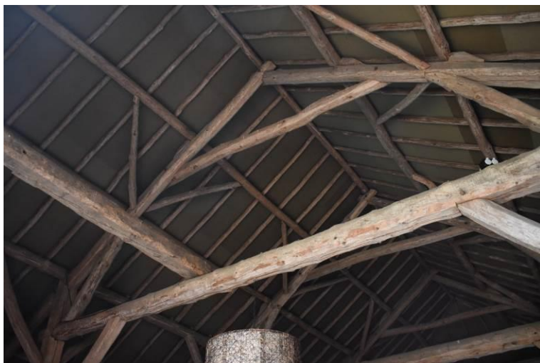
Dakconstructie vanaf de voorgevel gezien.
