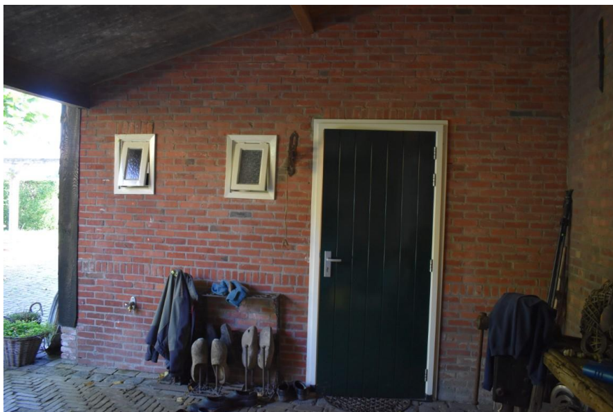
Linkerzijgevel van de aanbouw.
