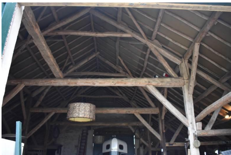
Dakconstructie vanaf de voorgevel gezien.
