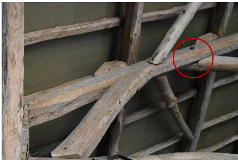
Bevestiging met bouten en moeren.
