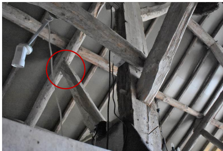
Telmerk III in rechterzijbeuk.
