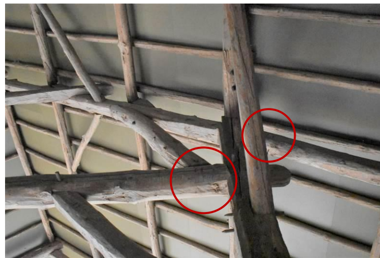
Telmerk II in linkerzijbeuk.
