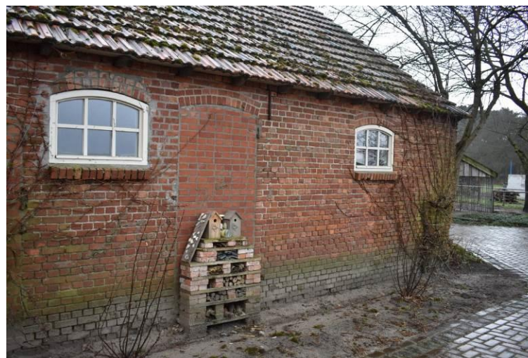
Dichtgemetselde staldeuropening.
