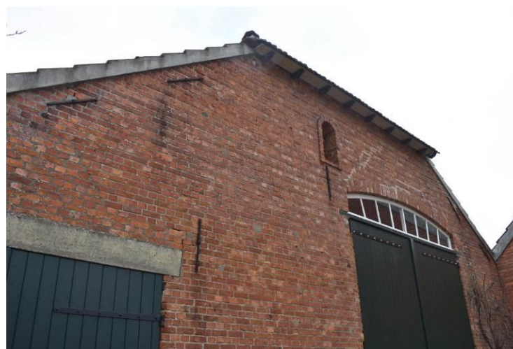
Detail dakoverstek ondersteund door houten klossen.
