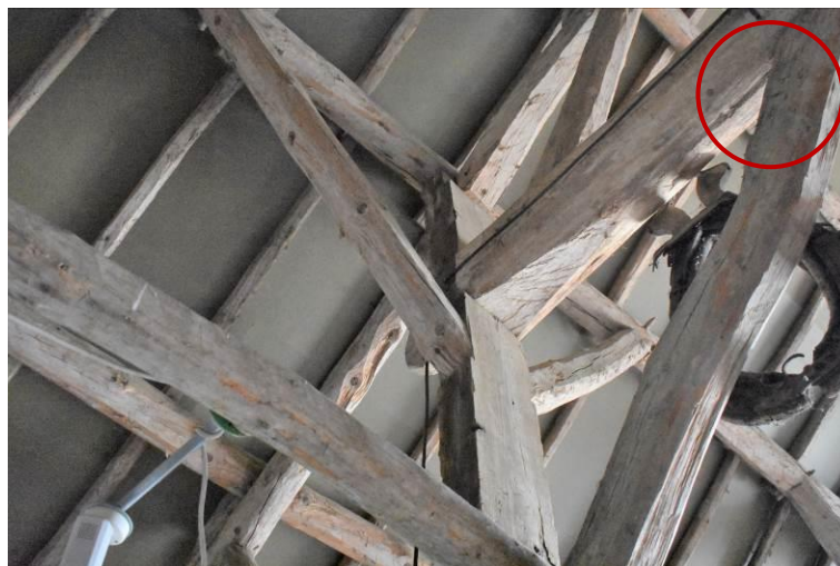
Telmerk III in rechterzijbeuk.
