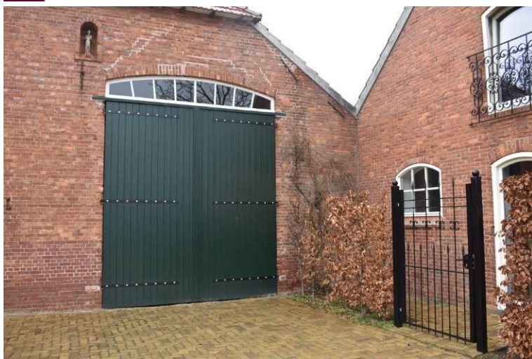
Vernieuwde langsdeeldeuren in de voorgevel.
