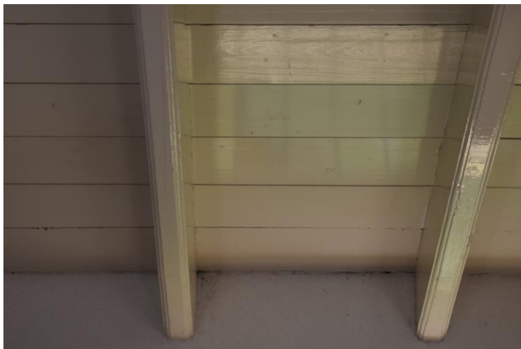
Balken plafond detailfoto.
