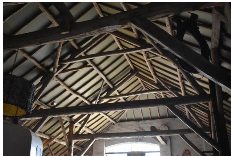
Dakconstructie vanaf de achtergevel gezien.
