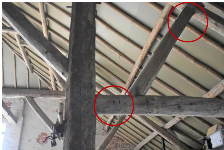
Telmerk II in linkerzijbeuk.
