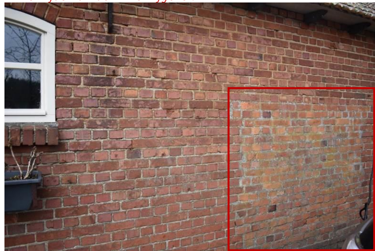
Groot oppervlak inboetwerk.
