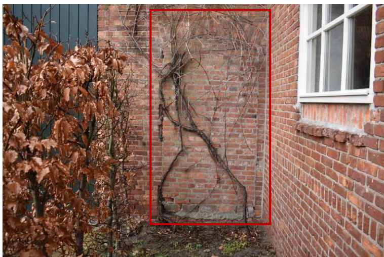
Rood omlijnd de dichtgemetselde deuropening in de rechterzijbeuk.
