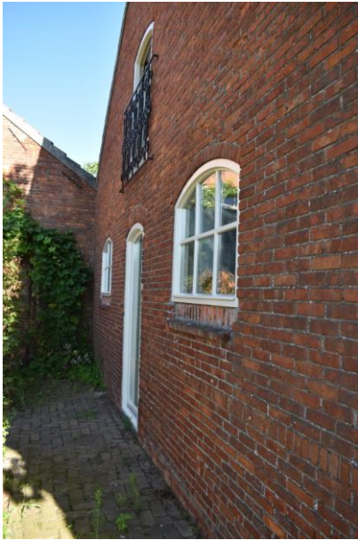
Linkerzijgevel met vernieuwde vensters.
