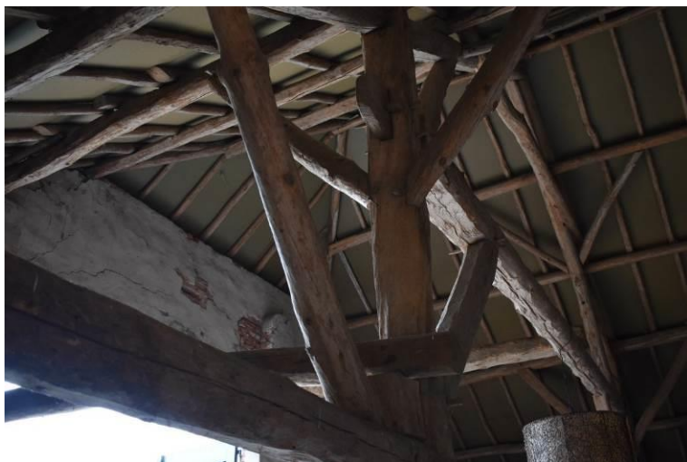
Detail constructie gezien vanuit de rechterzijbeuk.
