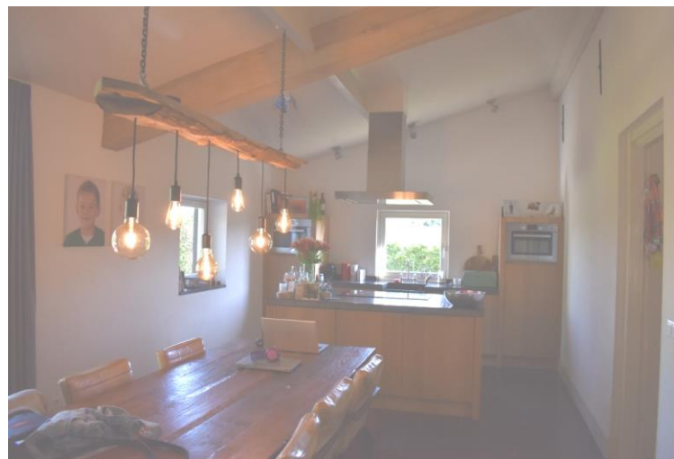
Keuken in aanbouw.
