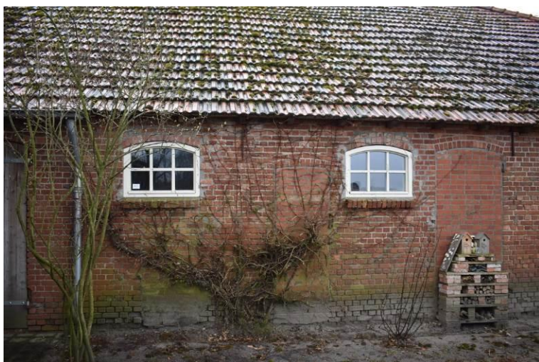
Vernieuwde houten zesruits stalvensters.
