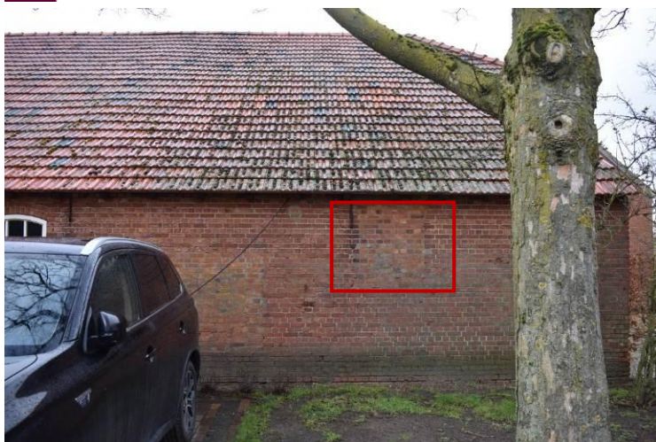
Rechterzijde van linkerzijgevel met dichtgezette raamopening.
