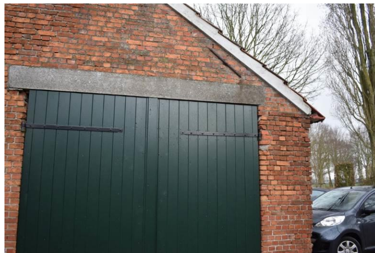
Vernieuwde zijlangedeuren onder een later ingebracht betonnen latei.
