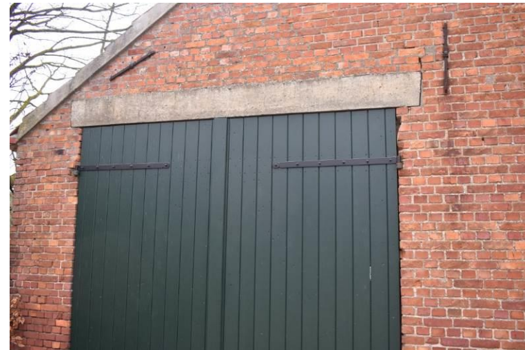
Vernieuwde zijlangsdeeldeuren onder een later ingebracht betonnen latei in de linkerzijbeuk.
