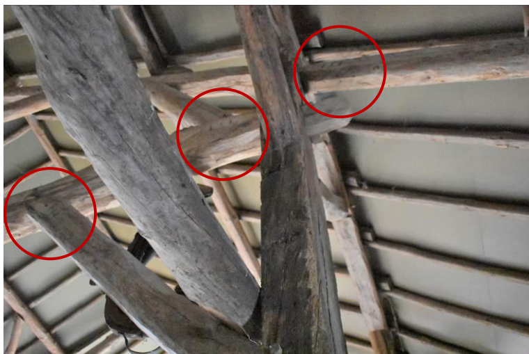
Telmerk III in linkerzijbeuk.
