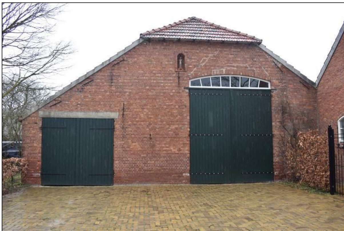
Afbeelding 1: Gevelaanzicht schuur, bron: redengevende omschrijving Monumentenhuis Brabant b.v.
