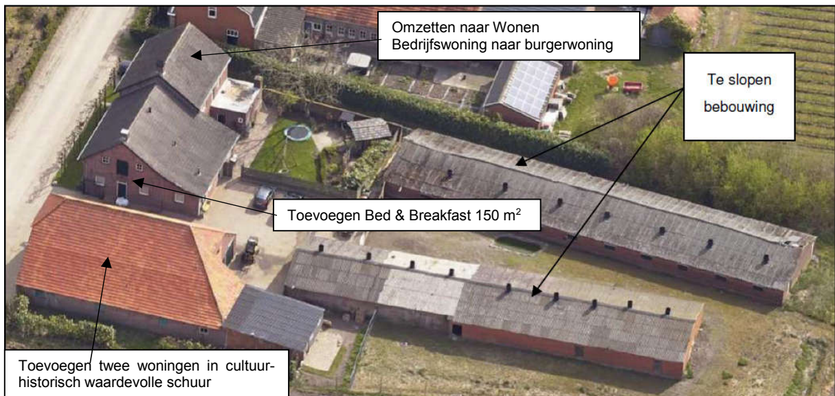
Figuur 12: Beeld met te slopen bebouwing en herbestemmingen binnen het plangebied
