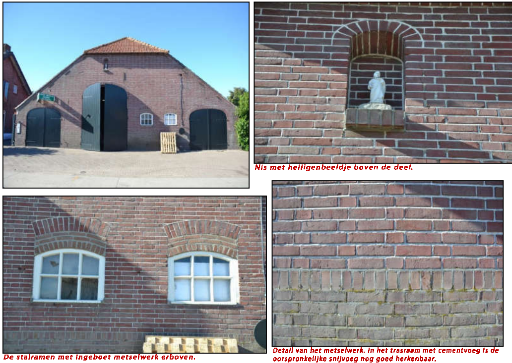
Figuur 22: Voorbeeld van behouden gebleven cultuurhistorisch waardevolle elementen aan de schuur, uit de Redengevende omschrijving, opgesteld door het Monumentenhuis
