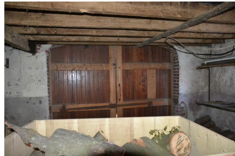
Staldeuren van linkerzijbeuk in de voorgevel, van binnenuit gezien.
