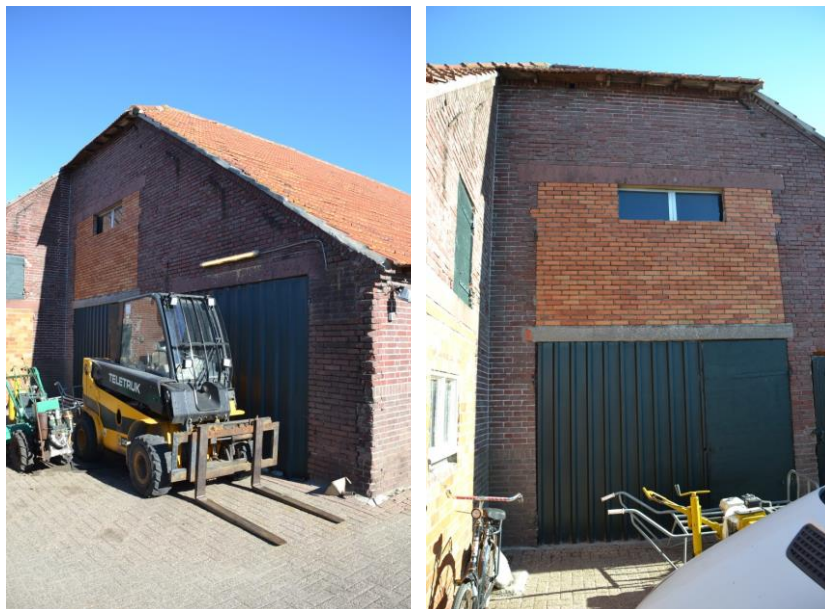
Links: achtergevel. Rechts: vm. deeldeuropening.
