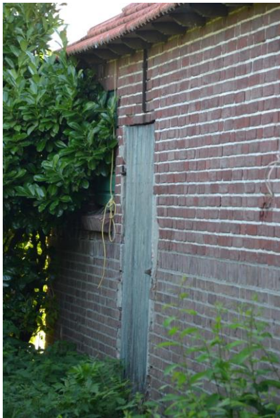
Vensteropening en loopdeur uiterst links in de gevel.
