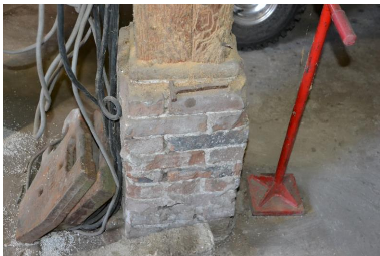
Een van de gemetselde poeren met houten slof.
