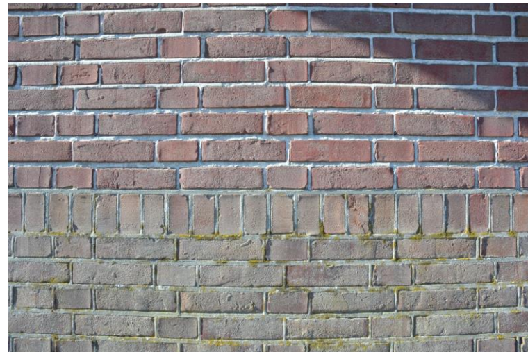
Detail van het metselwerk. In het trasraam met cementvoeg is de oorspronkelijke snijvoeg nog goed herkenbaar.
