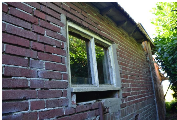
Detailopname van het betonvenster.
