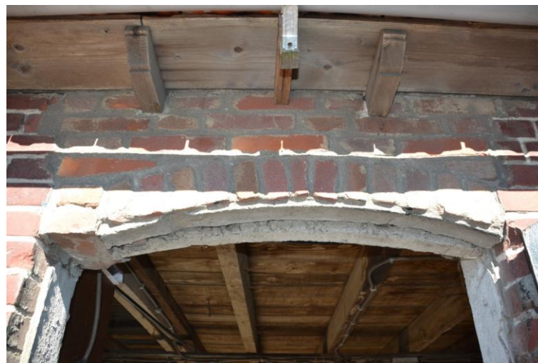
Detail van het inboetwerk boven de staldeur.
