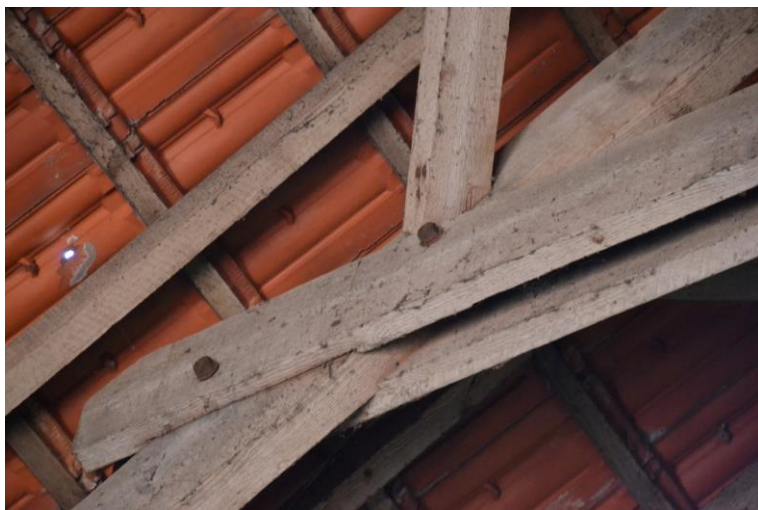
Bevestiging met bouten en moeren.
