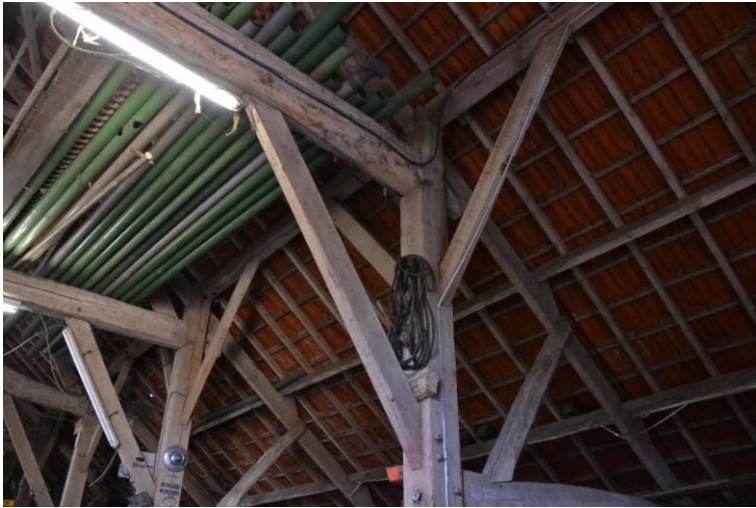
Gebintconstructie rechterzijde.
