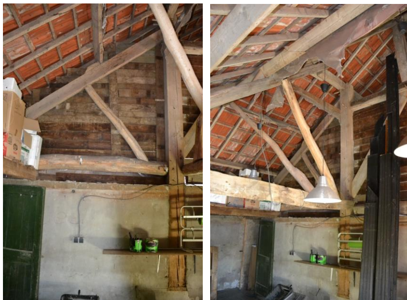
Links: scheiding tussen aanbouw en schuur met deels houten wand. Rechts: draagconstructie van de kap van de aanbouw.
