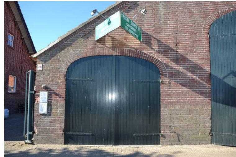
Staldeuren in de linkerzijbeuk.
