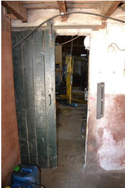
De houten schuifdeur tussen stal en deel.
