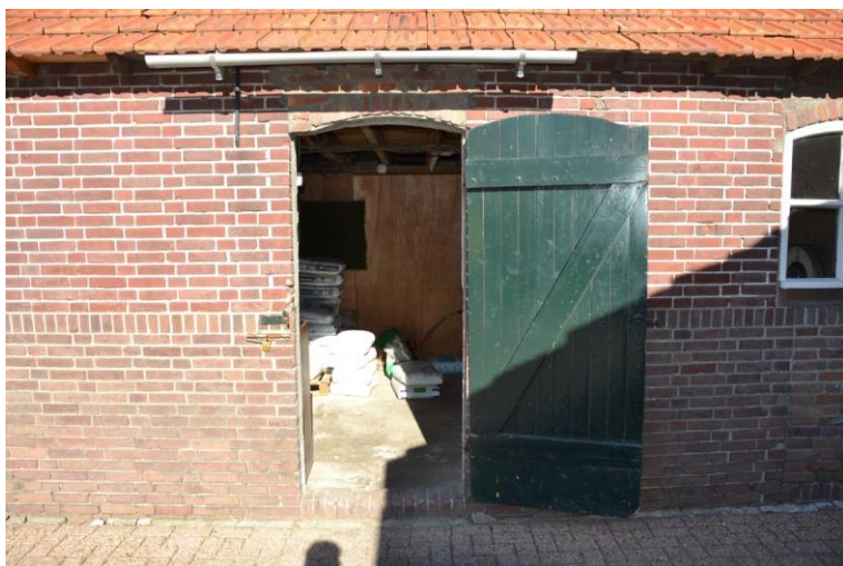
Loopdeur in linkerzijgevel.
