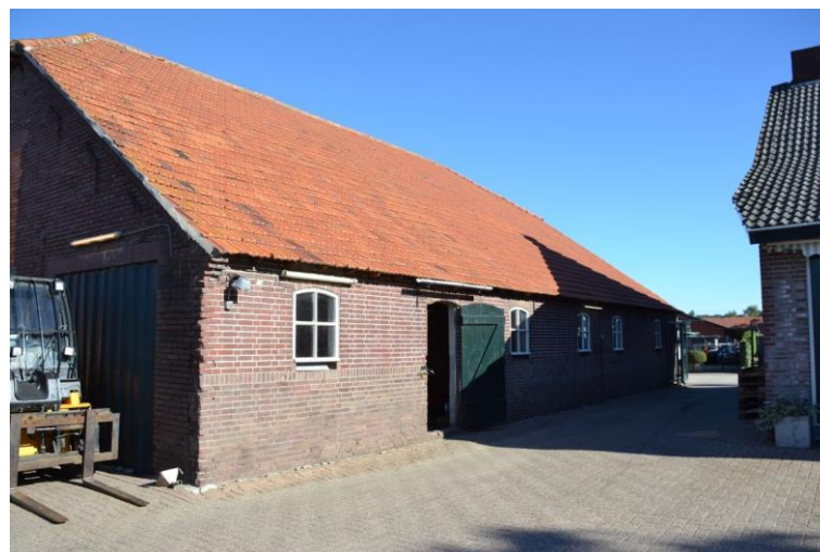
Linkerzijgevel vanaf het erf gezien.
