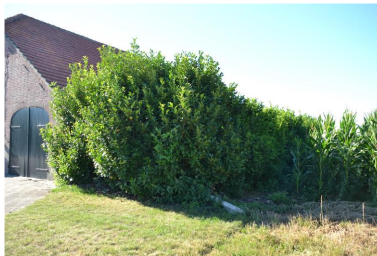
De rechterzijgevel (door struikgewas niet direct zichtbaar).
