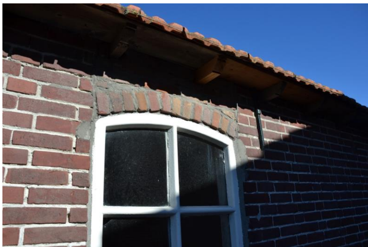
Ook boven het meest rechtse stalraam is inboetwerk zichtbaar.
