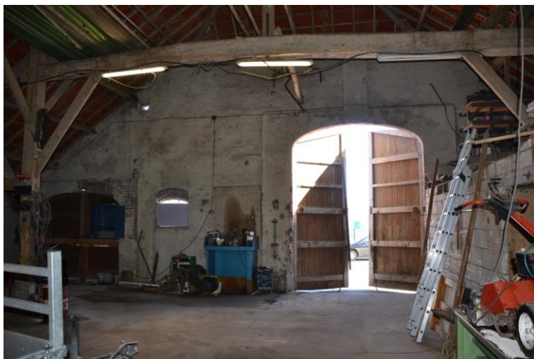
Links de staldeuren en rechts de deeldeuren vanaf binnen gezien.
