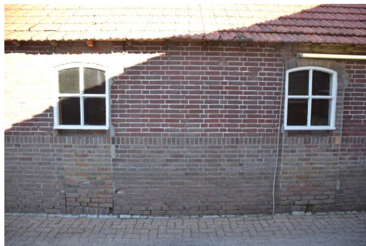
De stalramen met zowel boven, als onder inboetwerk.
