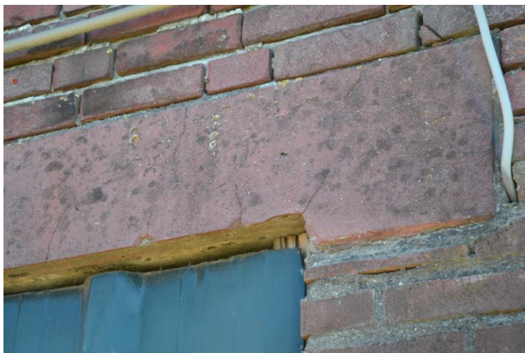
Detail van één van de oorspronkelijke lateien.
