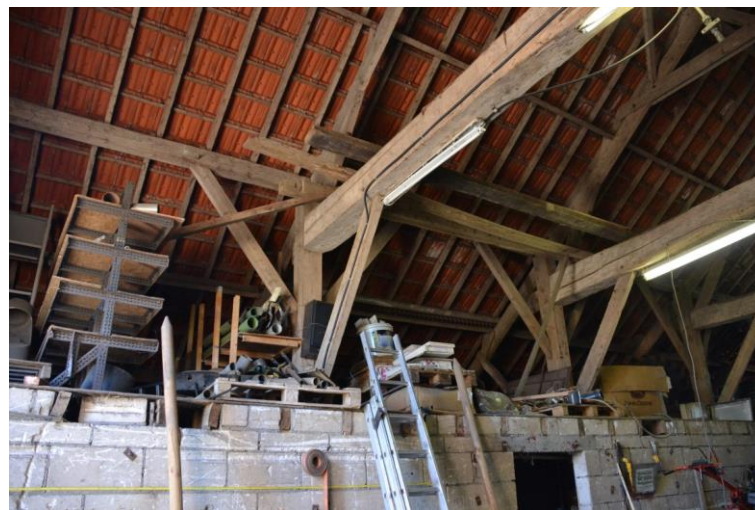
Gebintconstructie aan de linkerzijde.
