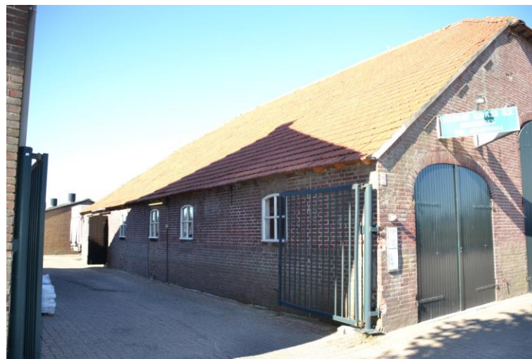
Linkerzijgevel vanaf de weg gezien.
