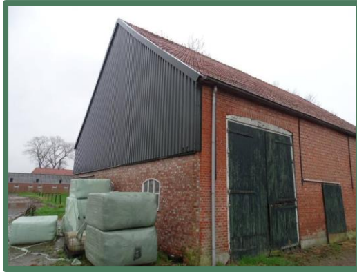
Afbeelding 18: Aangebouwde stal vanaf het noordwesten
