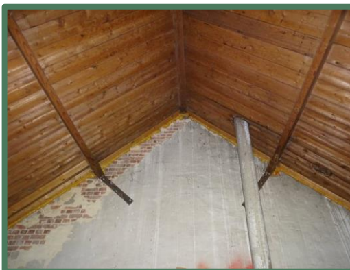
Afbeelding 17: Binnenzijde dak van het woonhuis
