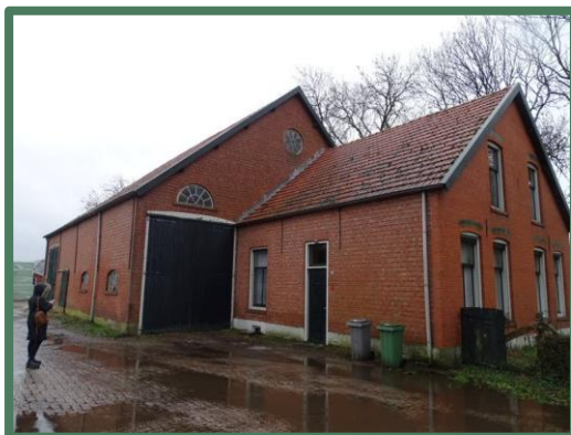
Afbeelding 16: Woning met stal vanaf het zuidwesten
