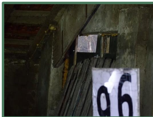
Afbeelding 42: Gat boven de deur in de wanden van de stal
