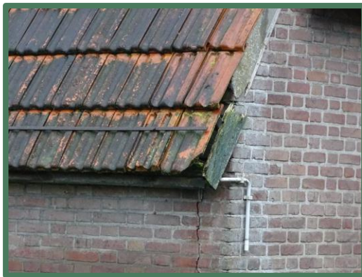
Afbeelding 35: Ruimte langs de zijgevel
