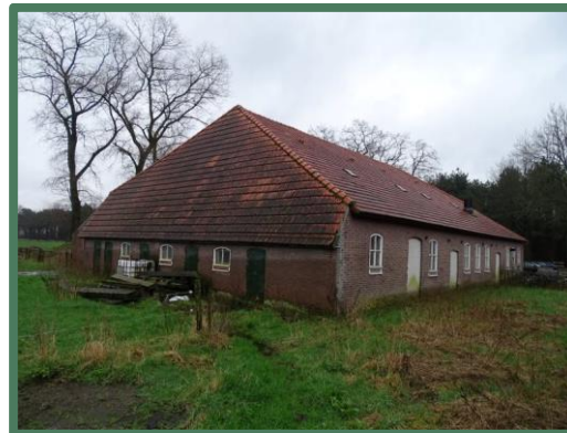
Afbeelding 23: Varkensstal vanaf het noordwesten
