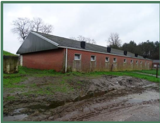
Afbeelding 28: Varkenstal (nummer 3) vanaf het noordwesten
