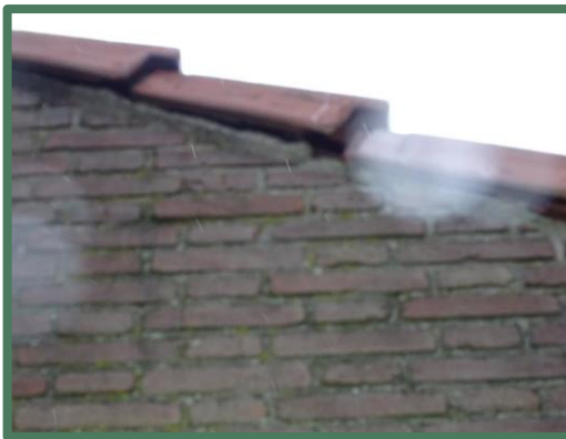
Afbeelding 36: Ruimte tussen de wanden en de dakpannen
