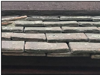
Figuur 2. Leien dakpannen bestaande uit verschillende lagen die dicht op elkaar gedrukt zijn.
