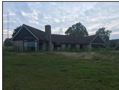
Figuur 3. Oostelijk aanzicht van het gebouw.
