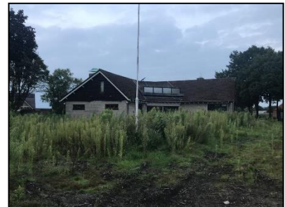
Figuur 4. Zuidelijk aanzicht van het gebouw.
