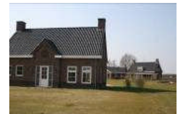
Nieuw gerealiseerde woningen
