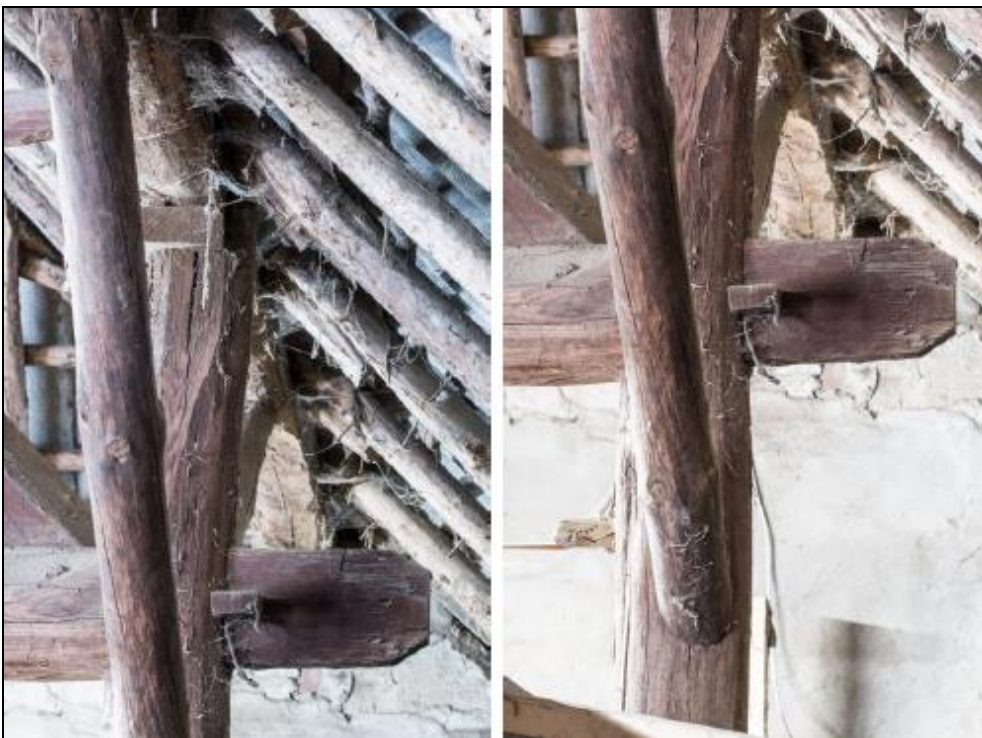
Figuur 10: Constructieprincipes met links ook een kesp onder de gebintplaat te zien. Rechts gespijkerd rondhout van het windverband aansluitend op de stijl
