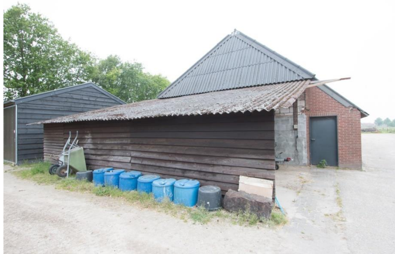
Linker zijgevel (straatzijde) met latere aanbouw. De gevel is in 1974 opgetrokken in kalkzandsteen (en vervangt vlechtwerk), de latere uitbreiding is in baksteen gemetseld.
