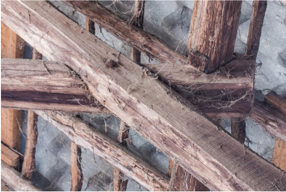
Zeer regelmatige (machinale) zaagsnede op één van de spantbenen en de aansluiting met de ingekeepte trekbalk. De verbinding is gebout. Rechts is te zien dat de fliering is ingelaten in de trekbalk. Ook zien we een wig onder de fliering.
