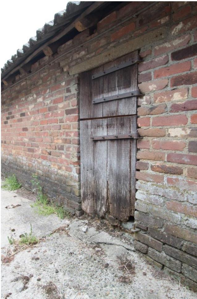
Varkensdeurtje onder een betonnen latei.
