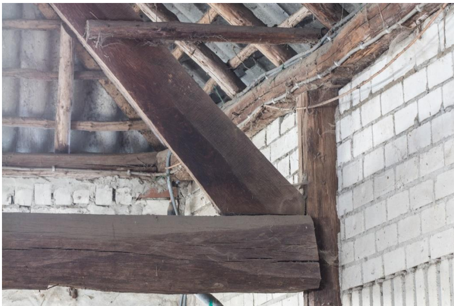
Constructieprincipe waarbij vooral goed te zien is dat het hout een onregelmatige dimensionering kent. Vermoedelijk zijn zowel de ankerbalk als het spantbeen zogenaamd wortelhout (onderste deel van de stam van de boom).
