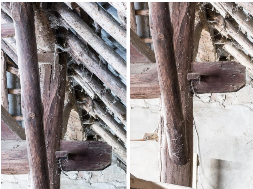
Constructieprincipes met links ook een kesp onder de gebintplaat te zien. Rechts gespijkerd rondhout van het windverband aansluitend op de stijl. De pen van de ankerbalk is opvallend lang.
