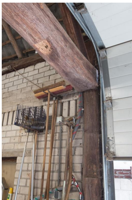
Aftekening van een verdwenen korbeel: spijkeren en borsten. Rechts het telmerk IIII.
