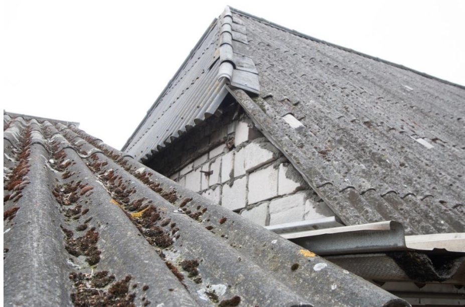
Kalkzandsteen in de rechter zijgevel.
