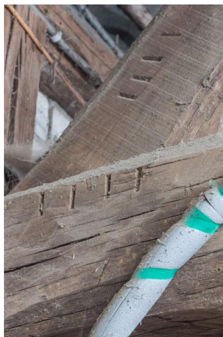
Aftekening van een verdwenen korbeel: spijkeren en borsten. Rechts het telmerk IIII.
