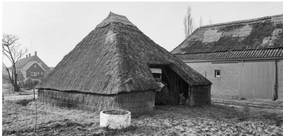
Karschop bij de boerderij. De landbouwschuur heeft soortgelijke wanden en dakkleding gehad. De bouwhistorische verkenning heeft aangetoond dat in deze streek net na de oorlog op deze traditionele wijze werd gebouwd. Normaliter wordt deze methode geassocieerd met eeuwen voorafgaande aan de twintigste.
