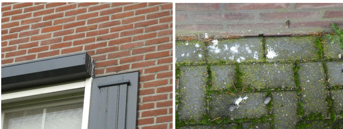
Afbeelding 17 en 18: sporen steenuil zuidzijde bestaande woning. Bron: BNL advies. Datum: 1-12-2022
