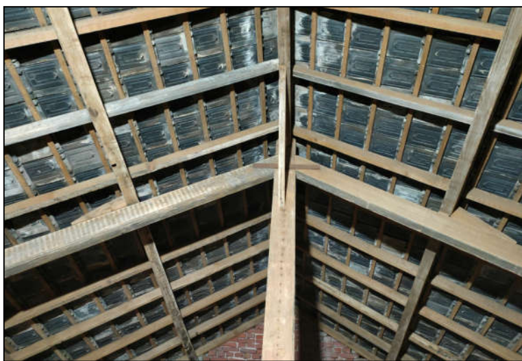
Figuur 30: Foto onderzijde dak
