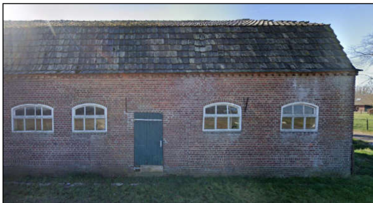
Figuur 25: Foto rechterzijde langsegevel met oude staldeur (Bron: Historische onderbouwing Sander Swinkels Bouwkundig Teken- & Adviesburo)
