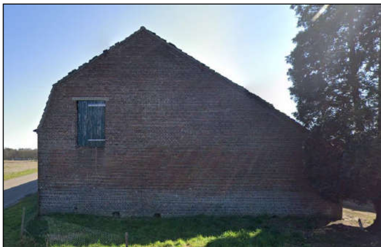
Figuur 26: Foto kopgevel westzijde (Bron: Historische onderbouwing Sander Swinkels Bouwkundig Teken- & Adviesburo)
