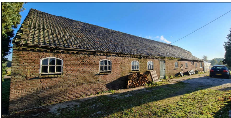
Figuur 27: Foto achterzijde (Bron: Historische onderbouwing Sander Swinkels Bouwkundig Teken- & Adviesburo)
