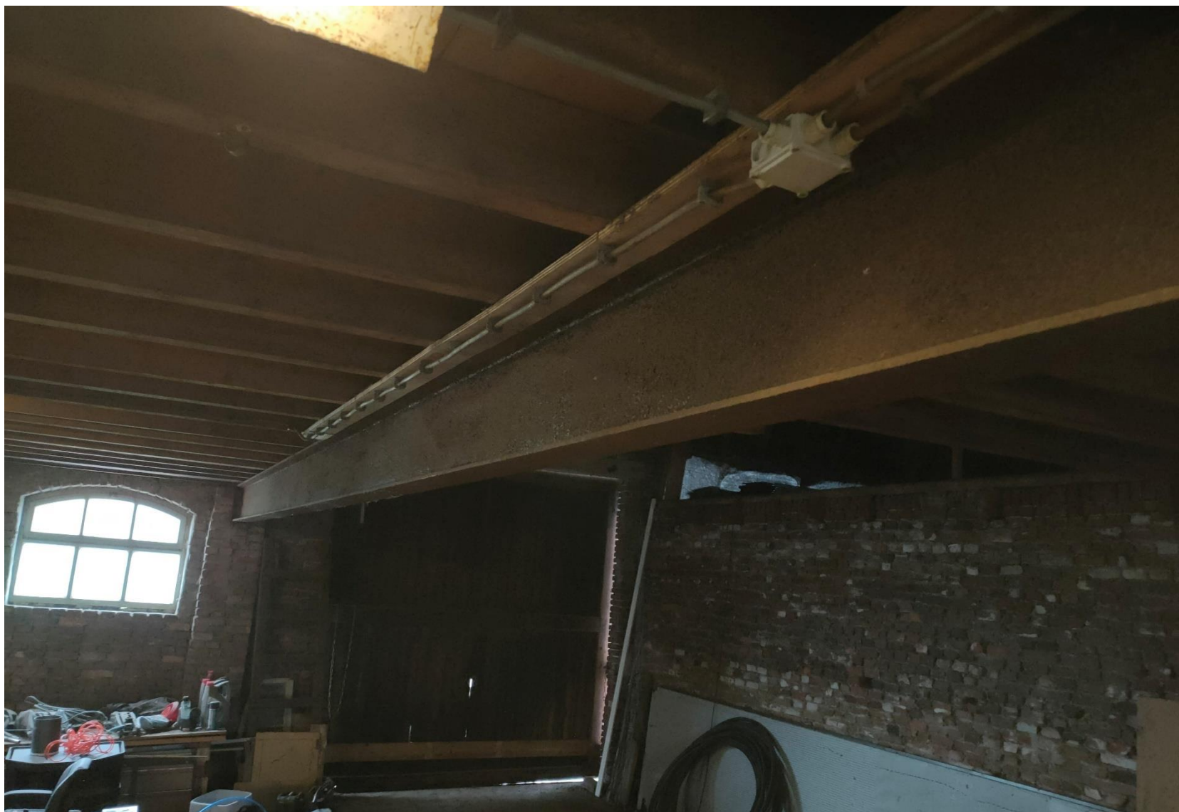
Foto van schuurgedeelte met daarop de stalen constructie t.b.v. verdiepingvloer (houten balklaag).
