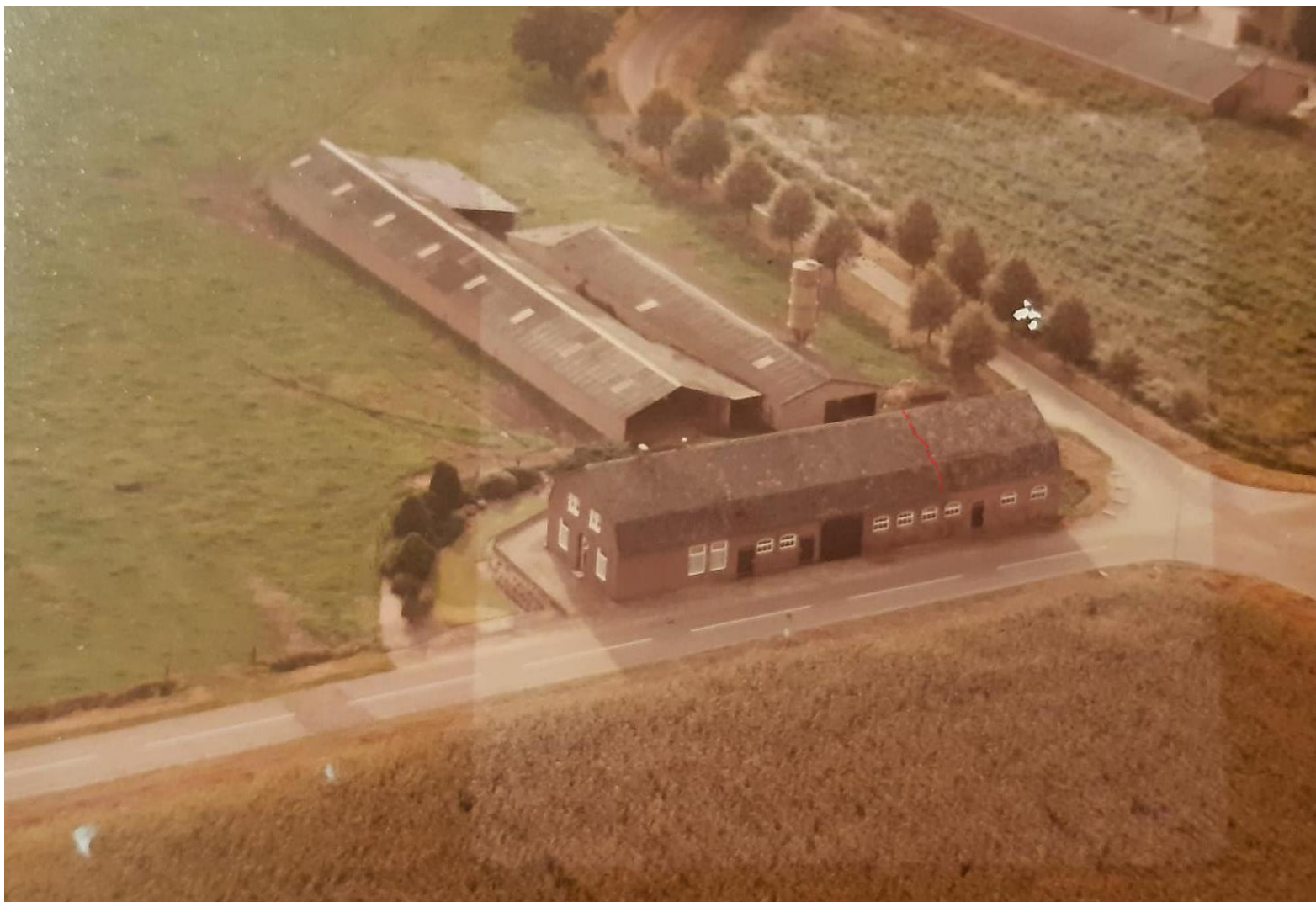
Oude luchtfoto van de boerderij. Jaartal onbekend. Aan het dakvlak kan men aflezen dat het rechtse gedeelte later is bijgebouwd. Dit dakvlak heeft een andere nuance. Ook zijn op deze foto nog alle bijbehorende stallen intact.
