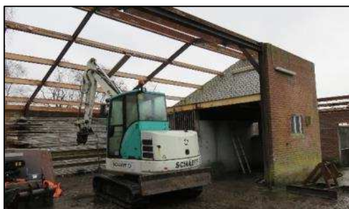
Foto 5. Te slopen gebouw
