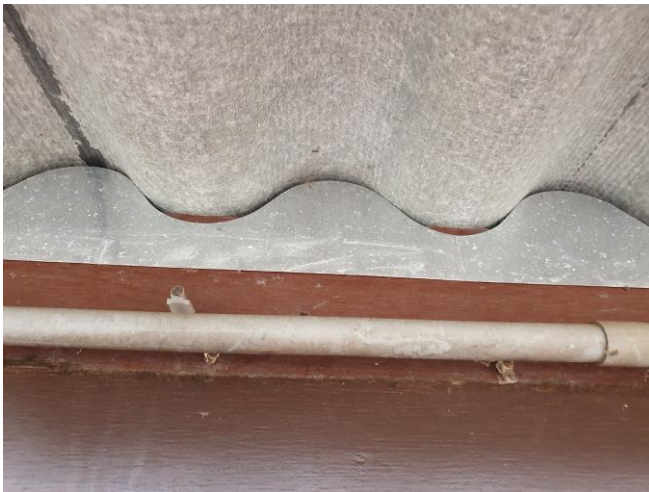
Afgedichte ruimtes onder de golfplaten van beide stallen.
