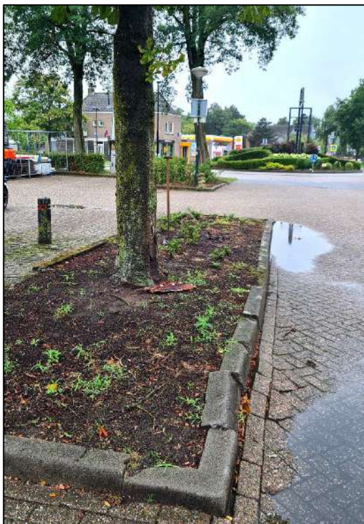
Afbeelding 9: Opsluitbanden worden weggedrukt door de wortels van boom 3.
