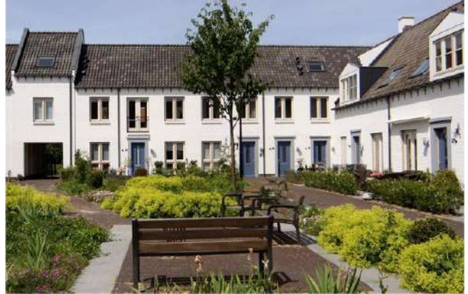
Referentie: appartementengebouw aan groen hof
