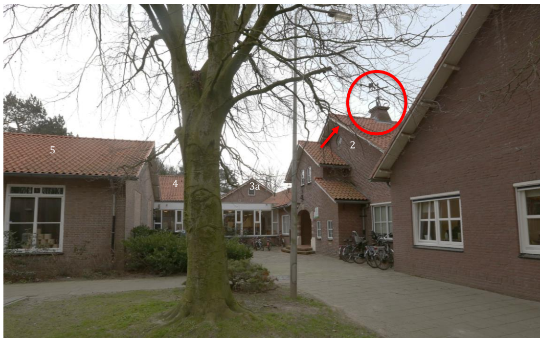
Figuur 5: Zicht op delen van de gebouwen 1, 2, 3, 4 en 5 gezien van noord naar zuid, (positie B in figuur 1). Zie bijlage 4 voor controle gevelpannen en schoorsteen o het voorkomen van gierzwaluw en vleermuizen.
