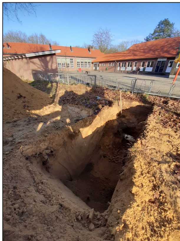
Figuur 12: vervolg profielsleuf 2 met buis op circa 100 cm minus maaiveld aan de zijde van het schoolplein.
