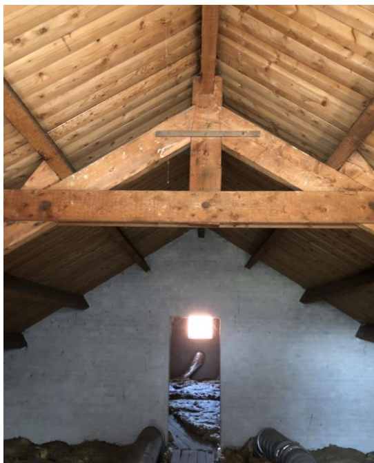
Figuur 18: Noordelijke zolder (3b in figuur 3).
