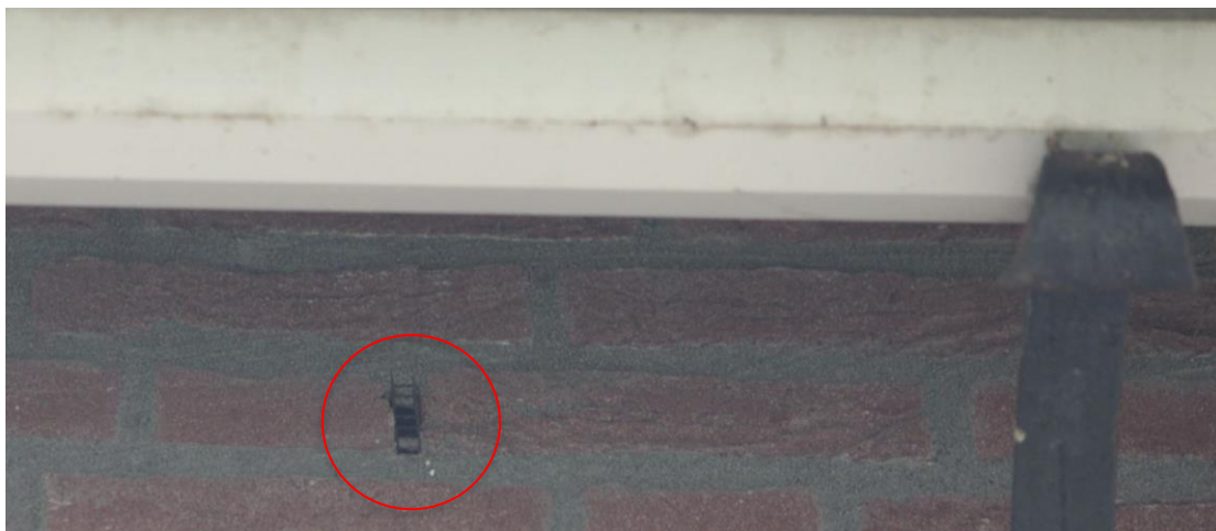
Figuur 8: Geveldetail: open stootvoegen met rooster.
