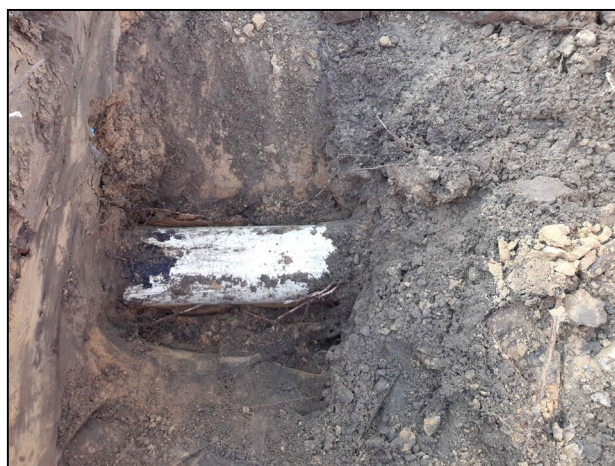
Figuur 12: vervolg profielsleuf 2 met buis op circa 100 cm minus maaiveld aan de zijde van het schoolplein.
