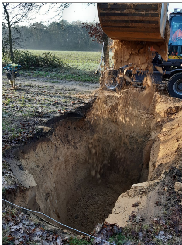
Figuur 10: Vervolg profielsleuf 1, aan de zijde van het schoolplein. In deze zone zijn geen kabels en leidingen aangetroffen.
