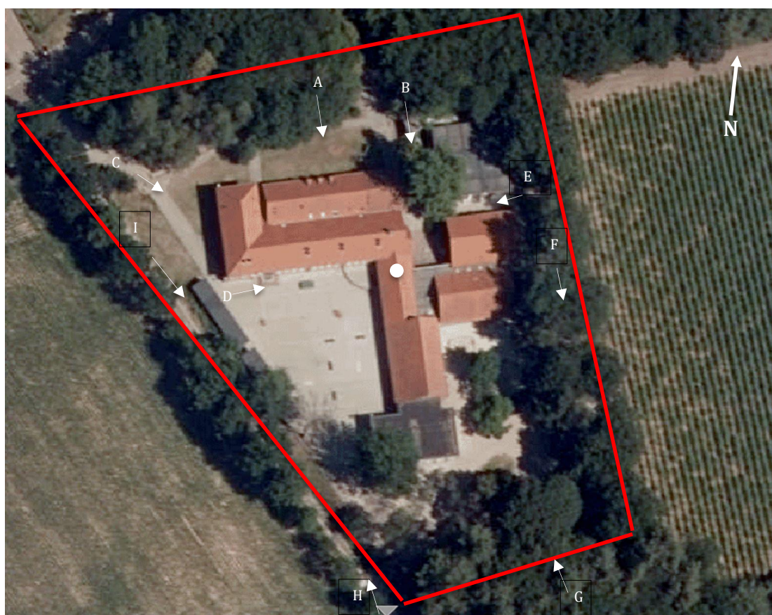
Figuur 1: Overzicht onderzoekslocatie te Asten. Rode arcering (dik): geïnspecteerde planlocatie. Pijlen A tot en met I duiden de posities aan vanuit waar onderstaande foto's zijn genomen. Witte stip: positie vleermuismonitoring.
