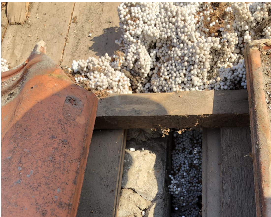
Figuur 11: Illustratie van isolatiemateriaal in de spouwmuren.
