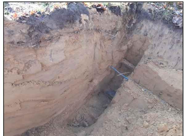
Figuur 11: profielsleuf 2 met kabels en leidingen strook op 1,2 meter uit het hart van de bomenrij.
