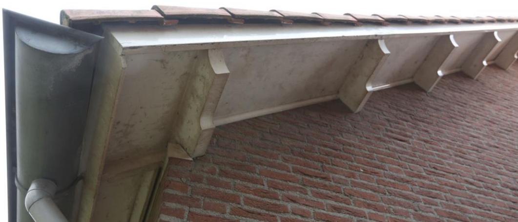
Figuur 10: Zijgevel met goed aansluitend houtwerk en brede overstekken.
