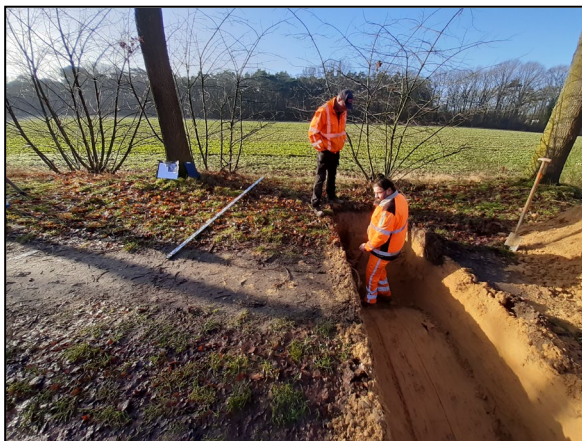
Figuur 11: profielsleuf 2 met kabels en leidingen strook op 1,2 meter uit het hart van de bomenrij.
