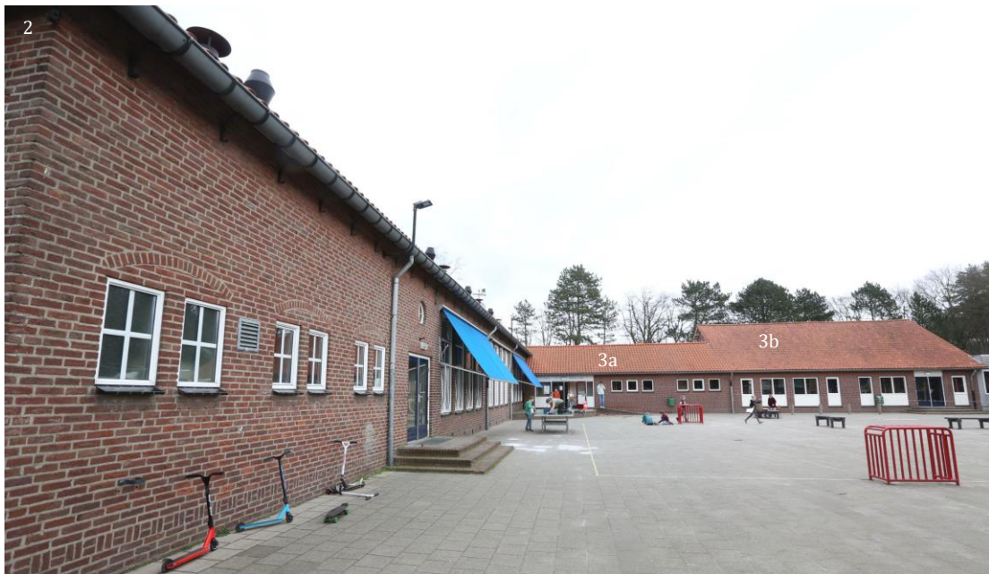
Figuur 7: Zicht op gebouwen 2 en 3 gezien van west naar oost, (positie D in figuur 1). Zolder 3b is voorzien van ramen waardoor het licht is op de zolders.
