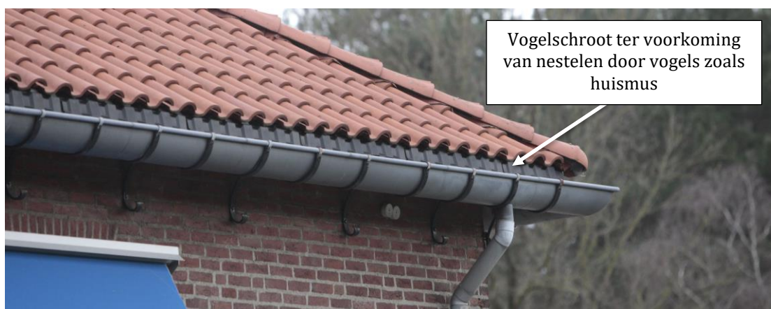
Figuur 12: Zicht vogelschroot dat toegang voor vogels tot de ruimten tussen dakbeschoot en pannen blokkeert.
