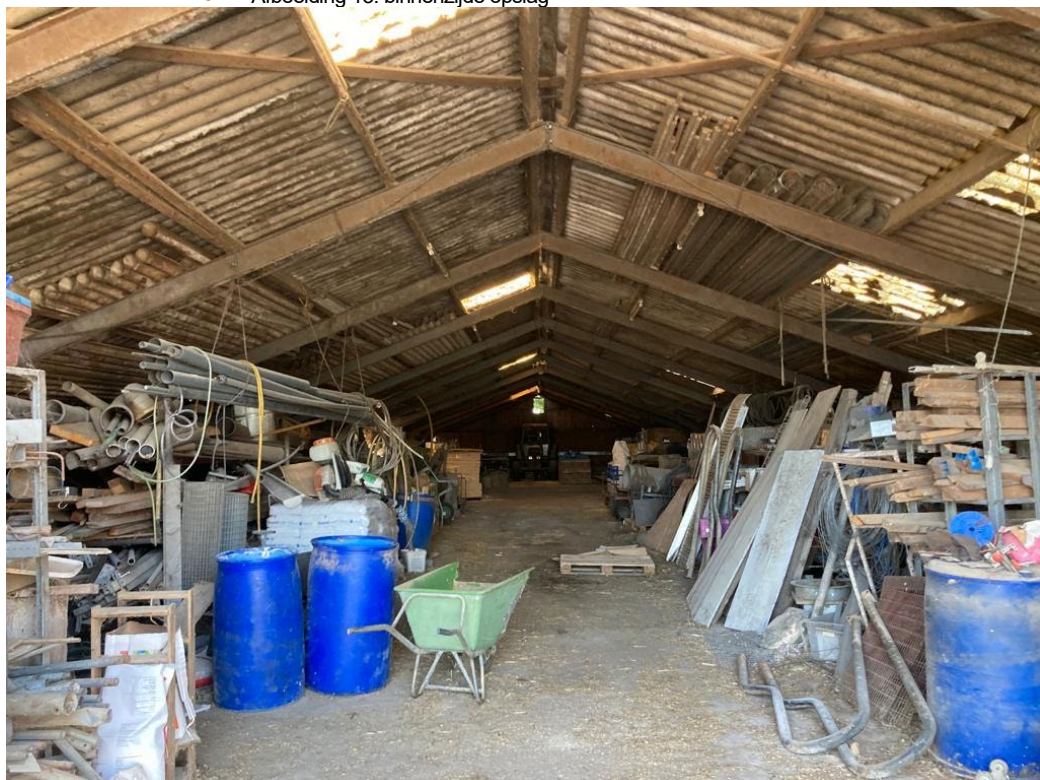
• Afbeelding 13: binnenzijde opslag
