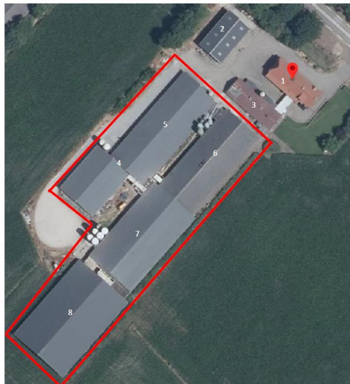
Binnen het rood kader de te slopen stallen
