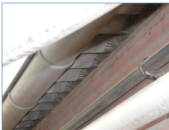
Foto's 9 en 10 'vogelschroot' in de openingen van de golfplaten gebouw 6 en 8
