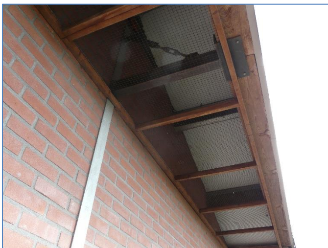
Foto 15 kierdichte bevestiging lucht
