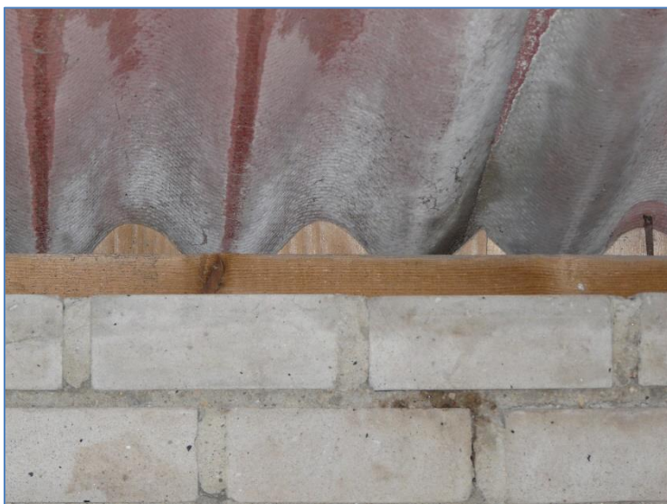
Foto 11 'plaat-golfafdichting' gebouw 2
