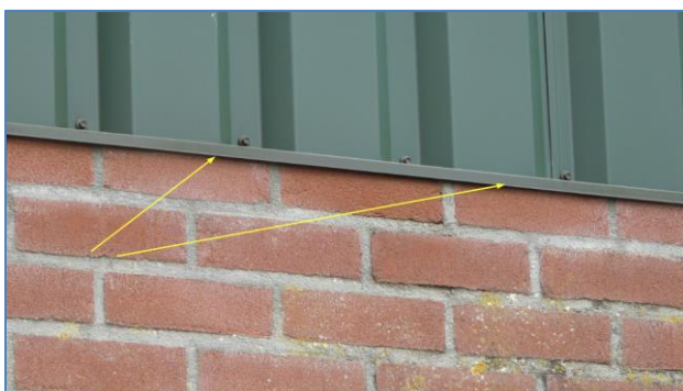
Fot 16 achtergevel gebouw 4 met afwerkljst damwand
