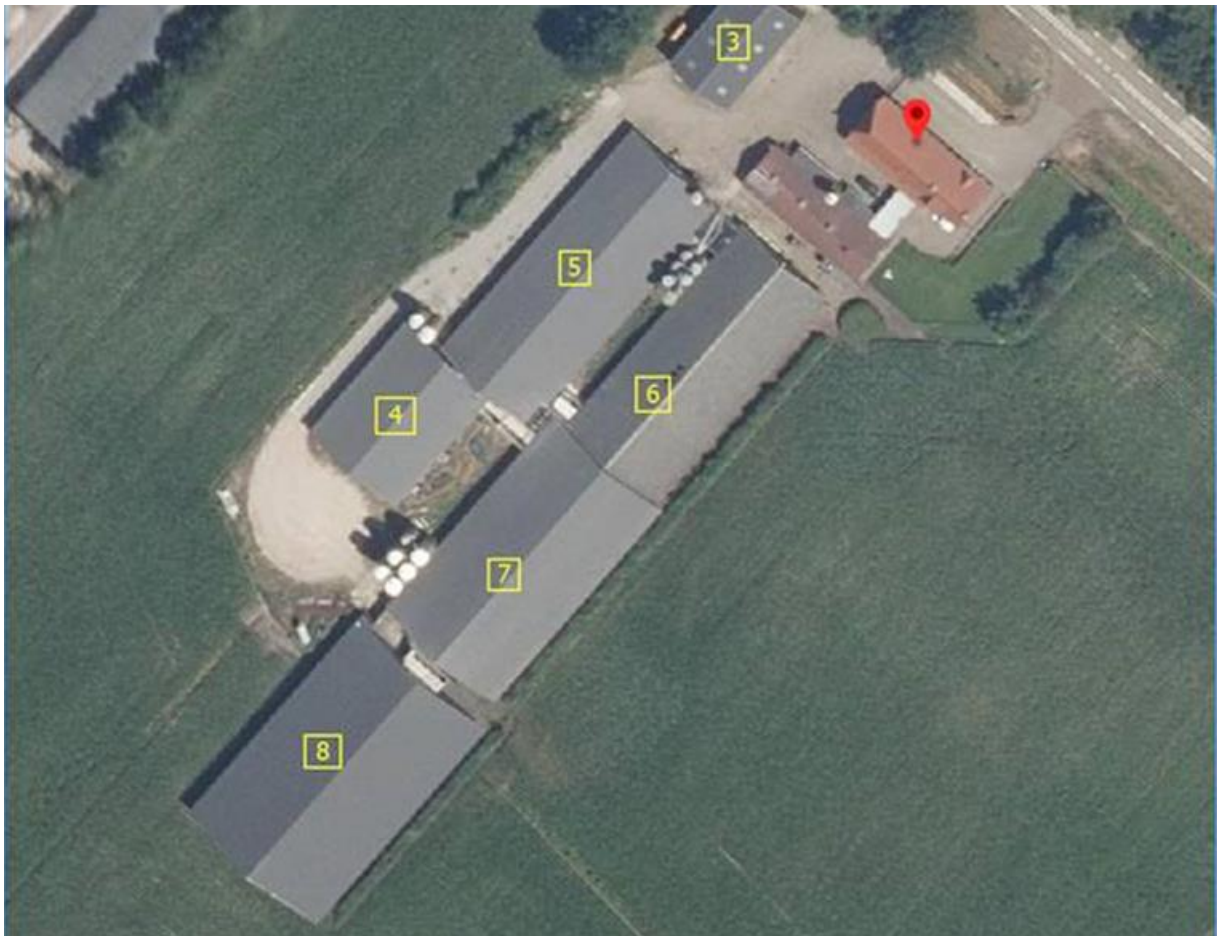
Figuur 1. Luchtfoto bedrijf met de te slopen opstallen. Gebouwen 4 t/m 8 (figuur 2) worden gesloopt en van gebouw 3 wordt het (asbest) dak gesloopt en vervangen.
