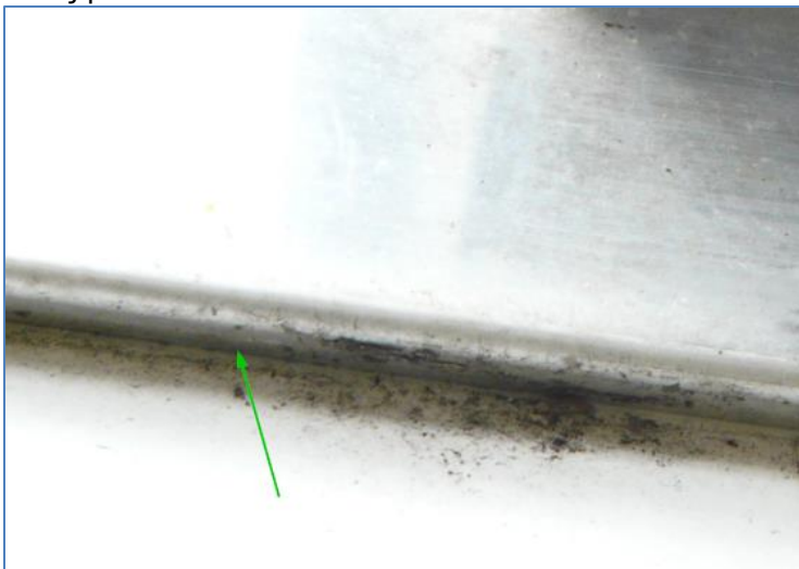
Foto 14 Kit-afdichting tussen daklijst platte tussenbouw gebouw 7 en 8
