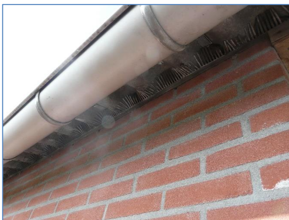
Foto's 9 en 10 'vogelschroot' in de openingen van de golfplaten gebouw 6 en 8
