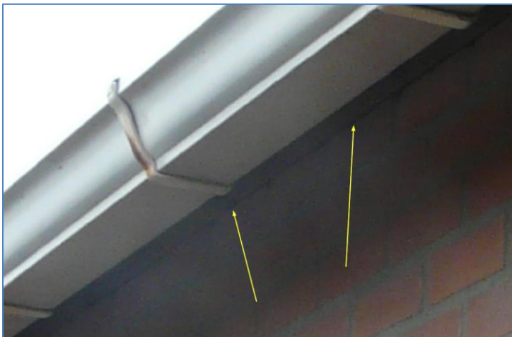
Foto 13 strak tegen de zijgevels aan gemonteerde goten met daarachter afdichtingsplank
