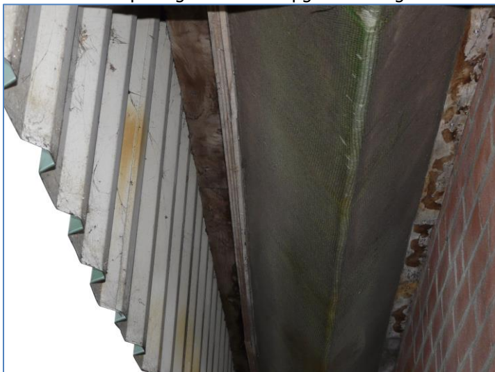
Foto 18 Met gaasdoek afgedichte luchtinlaatopening
