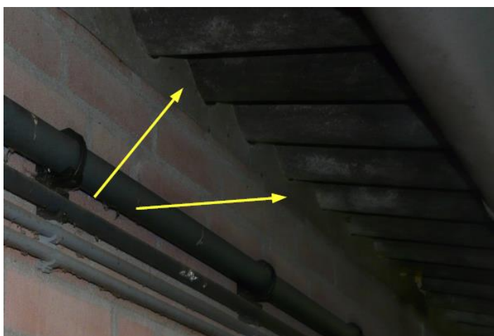
Foto's 8 'plaat-golfplaatafdichting' gebouw 4
