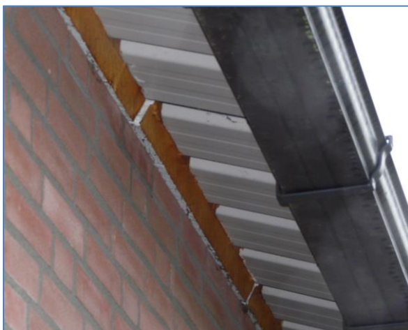
Foto 11 Afgedichte aansluiting dak en zijgevel gebouw 7.
