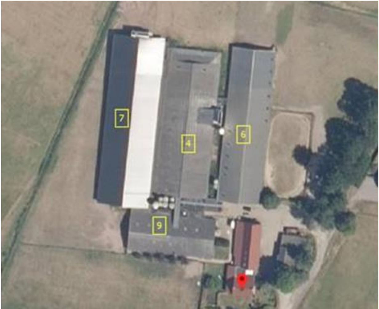
Figuur 1. Luchtfoto bedrijf met de te slopen opstallen. Gebouwen 4, 6, 7 en 9 (figuur 2) worden gesloopt.
