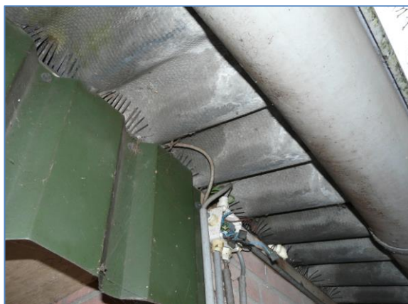
Foto's 9 en 10 'vogelschroot' in de openingen van de golfplaten gebouwen 6 en 9
