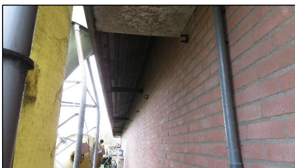
Foto 7. Aansluiting dak naar buitenmuur, gebouw 3
