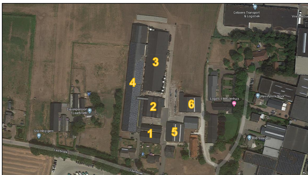
Figuur 3. De te slopen gebouwen genummerd (bron: Google Maps)
