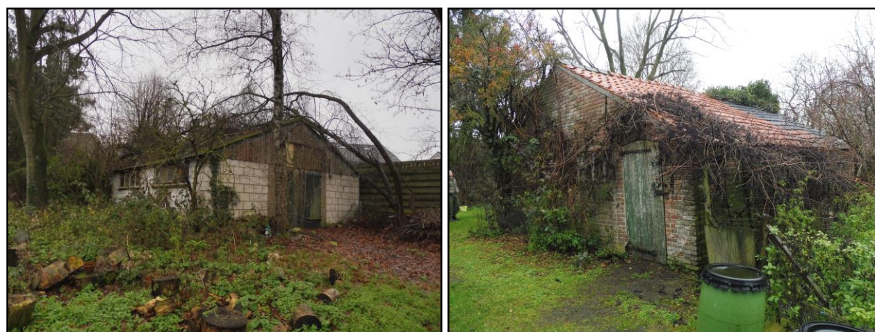
Te slopen garage/ werkschuur en kippenstalletje.
