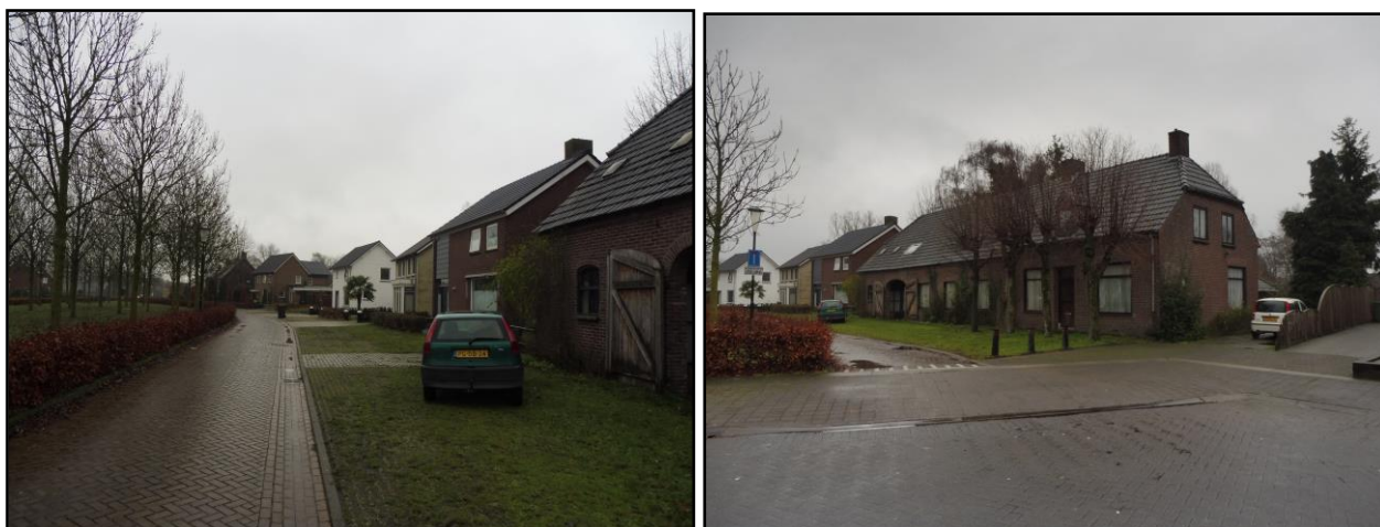
De directe omgeving plangebied, zicht op de Kloosterstraat en de te slopen langgevelboerderij.
