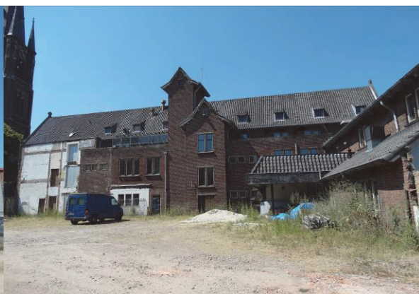
Figuur 6: Aanzicht achterzijde Bartholomeus complex
