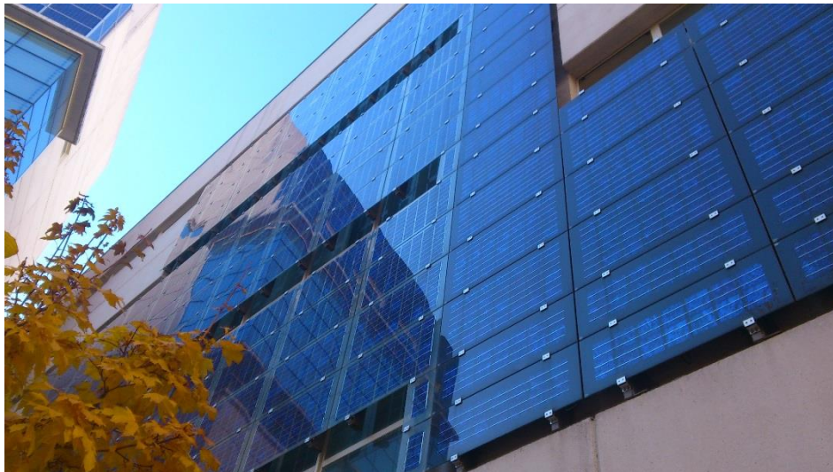
Voorbeeld gevel met solair energie
