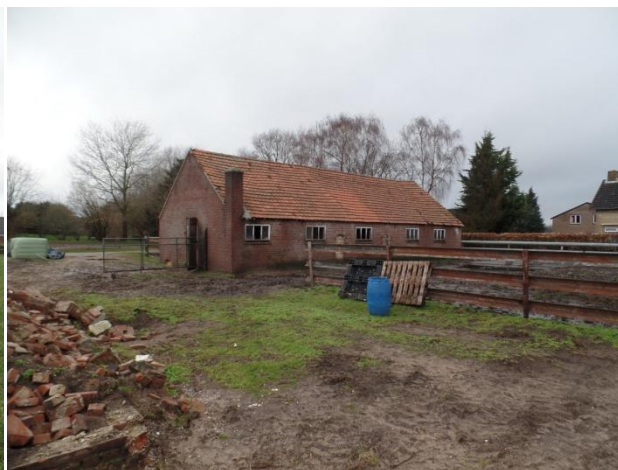
Fig.3 Stalgebouw op locatie Laarbroek 9
