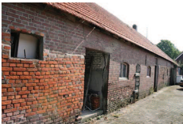
Achtergevel vanaf de linkerzijde
