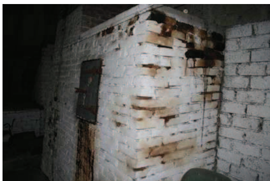
Brandmuur en schoorsteen op de zolder
