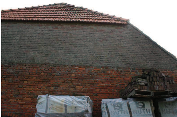
Vernieuwd metselwerk verdieping
