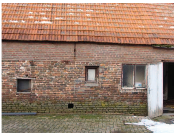
Achtergevel boerderij met bouwsporen
