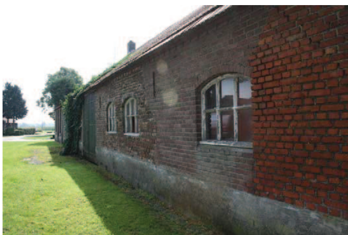
Voorgevel vanaf rechterzijde
