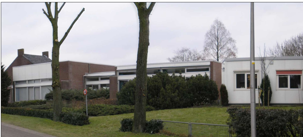
bestaande bebouwing school aan de Heikamperweg
