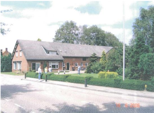
Woning Meijelseweg 17 met stalgedeelte (stalgedeelte is gesloopt)
