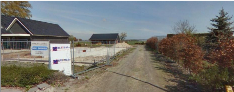
Voorgrond bouwput nieuwe woning, achtergrond paardestal
