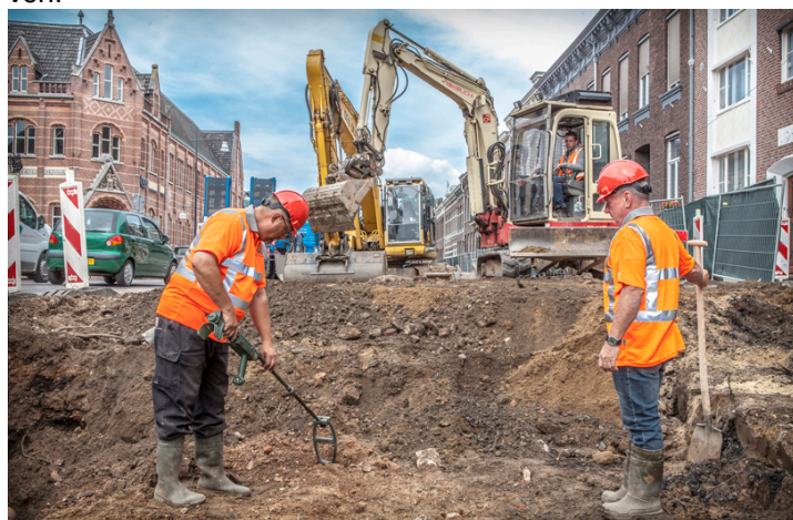
Afbeelding 13. Uitvoeren actieve realtime oppervlakedetectie m.b.v. Vallon VMM/ VMH3CS non Ferrous Locator en staafdiagram waarop het maximale detectiebereik (m1 – mv) per kaliber is aangegeven.
