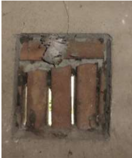
Figuur 7. Ventilatiesleuf in schuur
