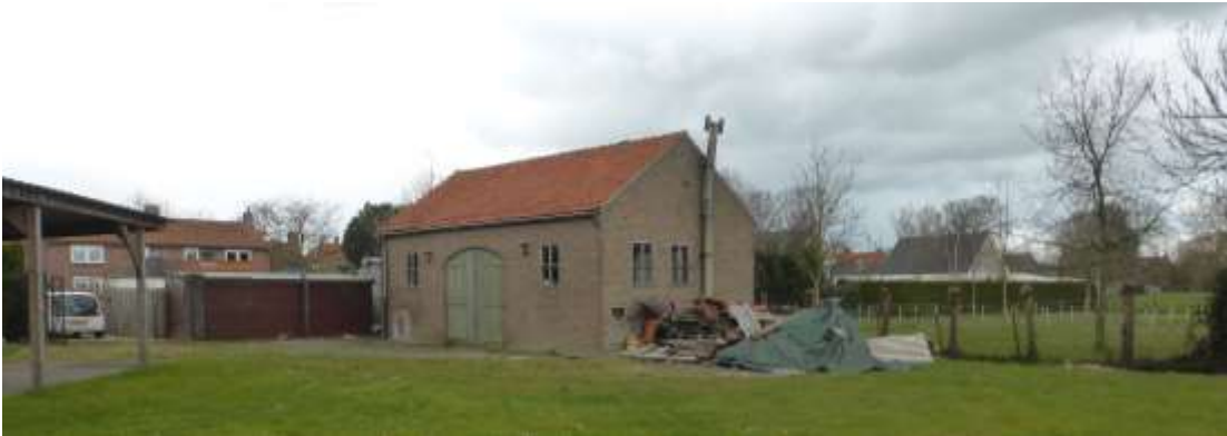
Figuur 2. Noordelijke perceel met opstal
