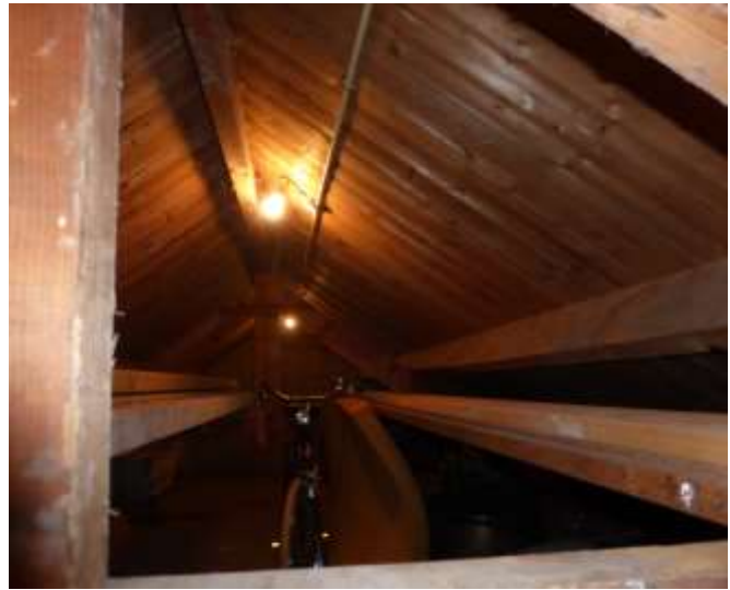
Figuur 8. Dak van schuur op de zolder
