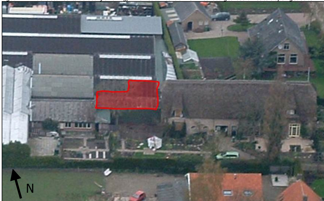
Figuur 2.2: Luchtfoto rechts de bedrijfswoning, links het tuincentrum en met rood gearceerd het te slopen gedeelte.
