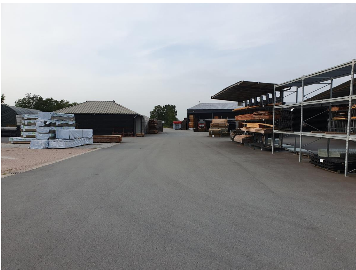
Figuur 9. Het westelijk deel van het plangebied (links) met laadgebouw voor elektrisch materieel.
