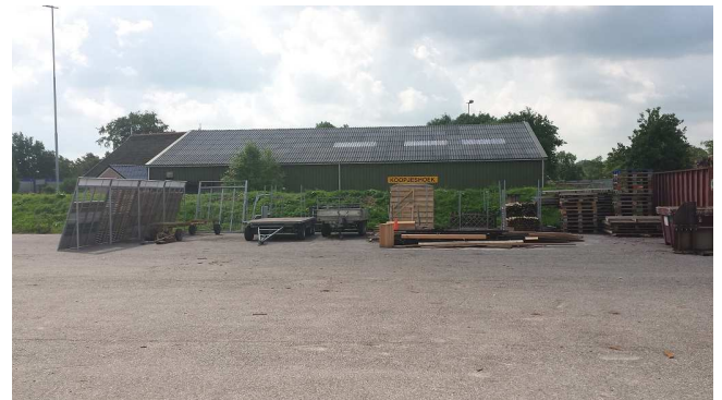
Toekomstige locatie overkapping op zuidelijk deel terrein.
