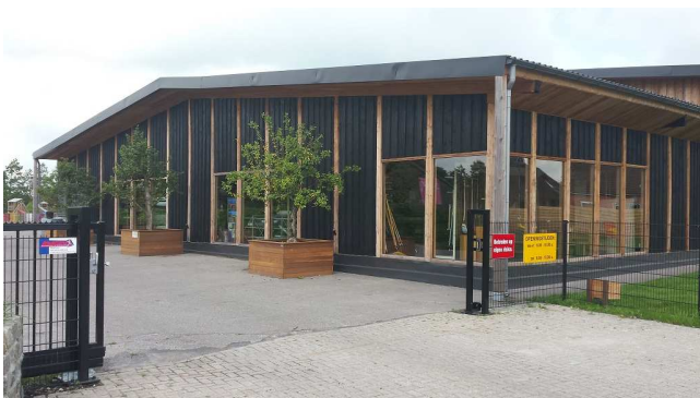
Verkoopruimte in zuidelijk deel kapschuur c.q. overkapping
