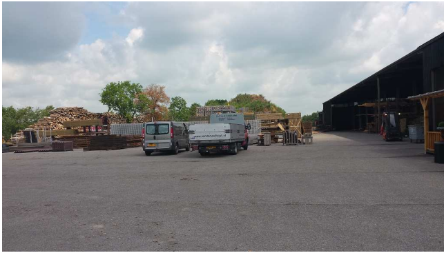
Achterterrein ten westen van kapschuur c.q. overkapping
