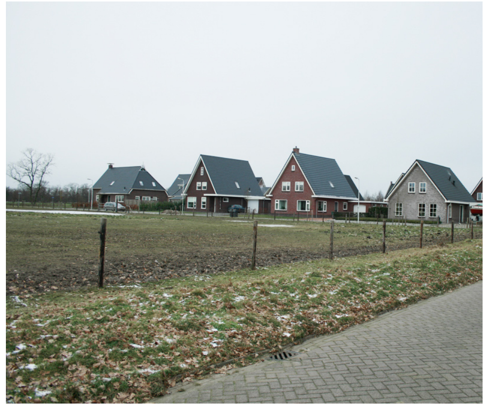
nieuwbouw aan de Hanegraaffweg
