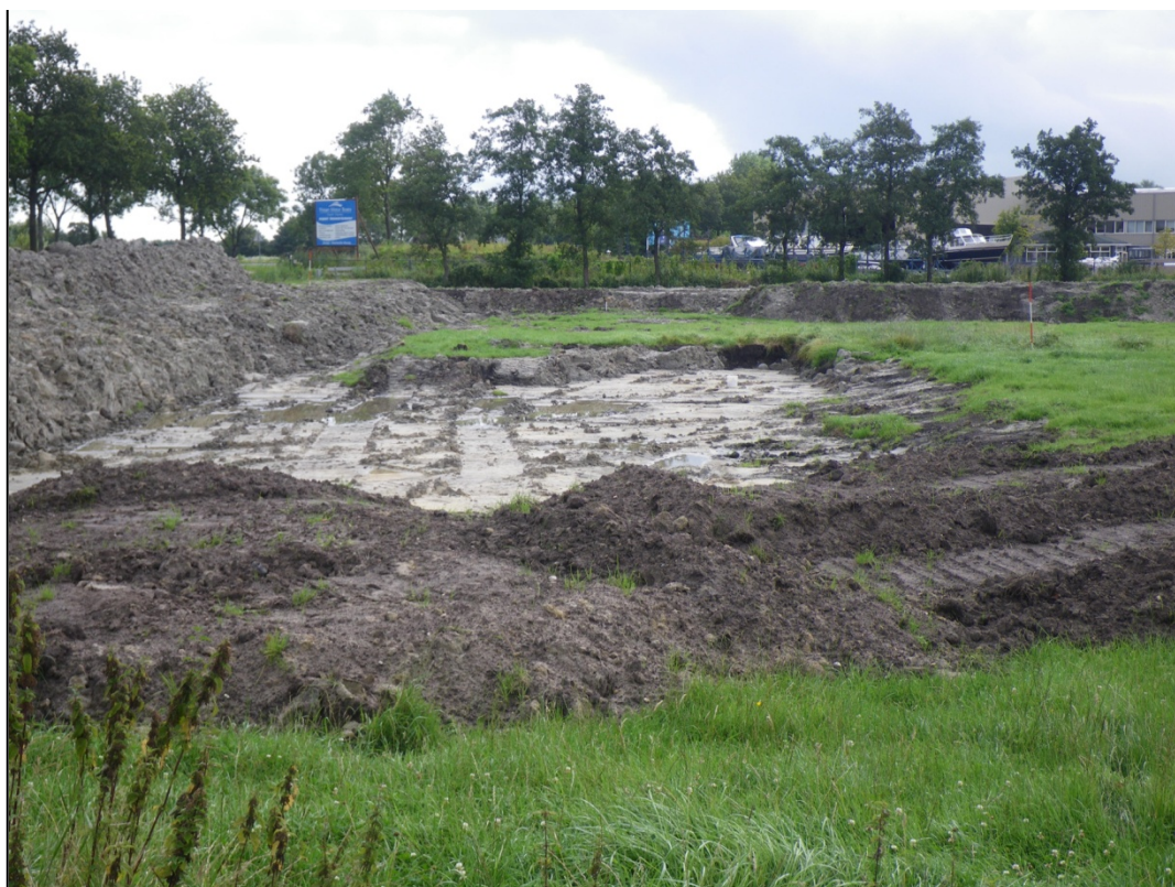
Fig. 5.2: Afgraving ter plaatse van boorpunt 7 gezien vanuit het noordwesten.
