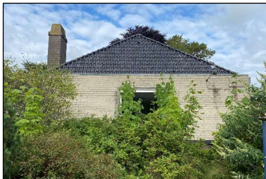
Afbeelding 2.2. Oostzijde van het gebouw
