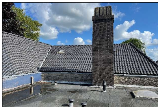
Afbeelding 2.7. Dichtgemetselde schoorsteen
