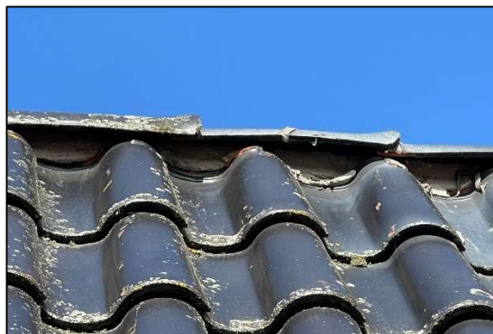
Afbeelding 2.9. Dichtgemetselde nokvorsten
