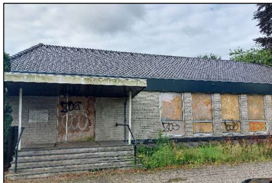
Afbeelding 2.3. Noordzijde van het gebouw
