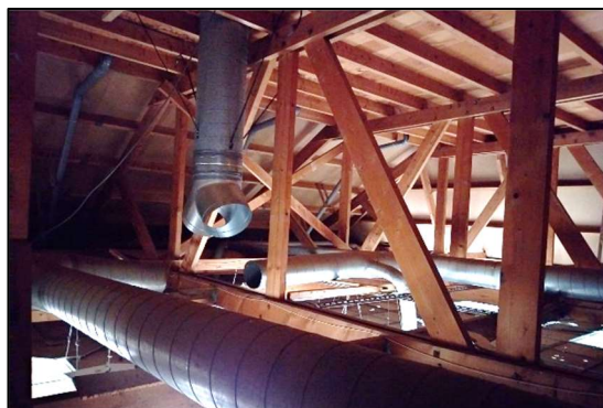
Afbeelding 2.15. Ruimte boven het systeemplafond
