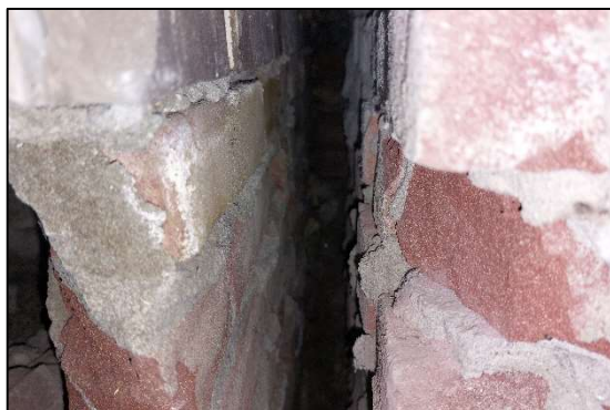
Afbeelding 2.14. Spouwmuur
