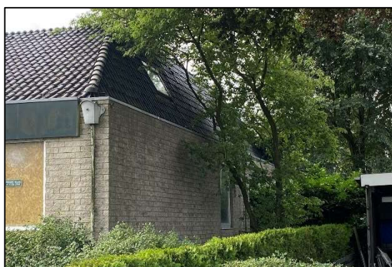
Afbeelding 2.4. Westzijde van het gebouw
