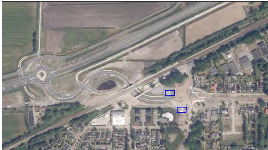
Afbeelding 1.1 Overzicht projectgebied (appartementencomplex 1 en 2 = blauw)
