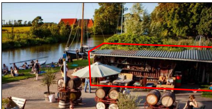
Figuur 4.2 Te slopen bouwwerk
