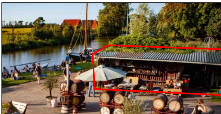
Figuur 4.2 Te slopen bouwwerk
