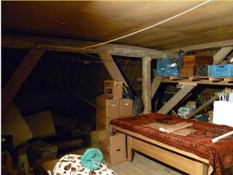
Foto 3. (bron Funda). Zolder op de eerste verdieping. De afgesloten zolder (boven het zichtbare plafond) is mogelijk een geschikte ruimte voor verblijfplaatsen van (Meer)vleermuizen.
