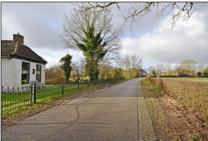
Figuur 4: Ielke Boonstraloane ter hoogte van het bouwplan met de te slopen woning (bron Funda)
