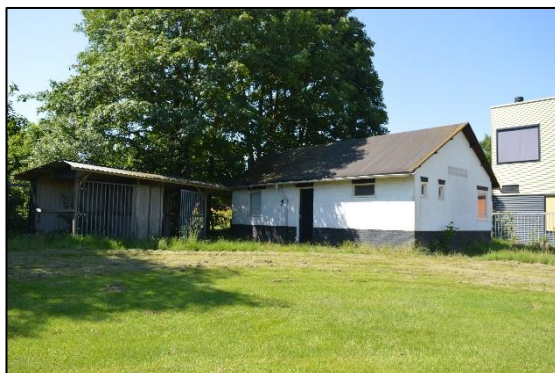
Afbeelding 2.6. Gebouw met overkapping.
