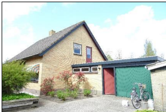
Afbeelding 2.2. Woonhuis met aanbouw.
