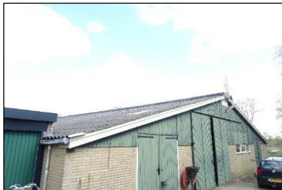
Afbeelding 2.3. Te slopen schuur.
