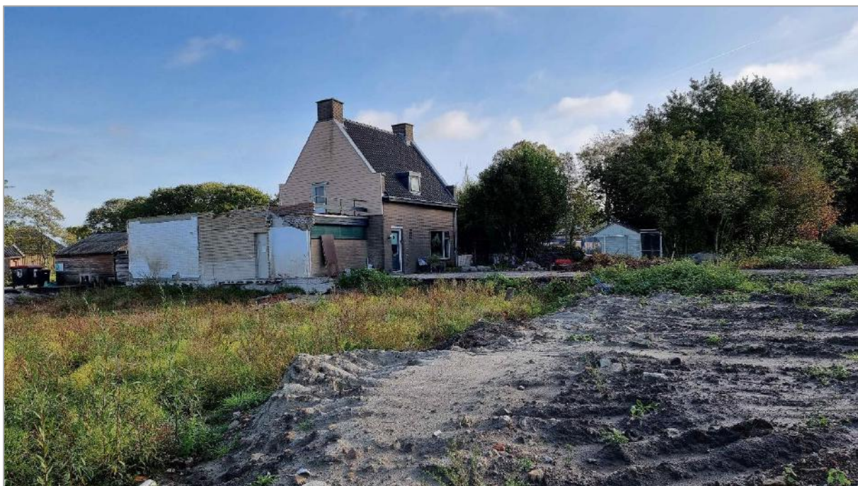
Woning Sanjesreed 8A met resterend muurdeel gesloopte bebouwing. Foto richting oosten.
